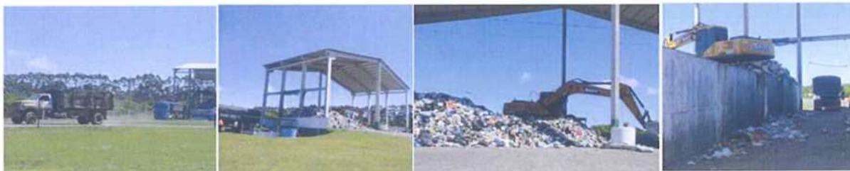
Figura 7 – Transbordo de resíduos domiciliares da CRVR
