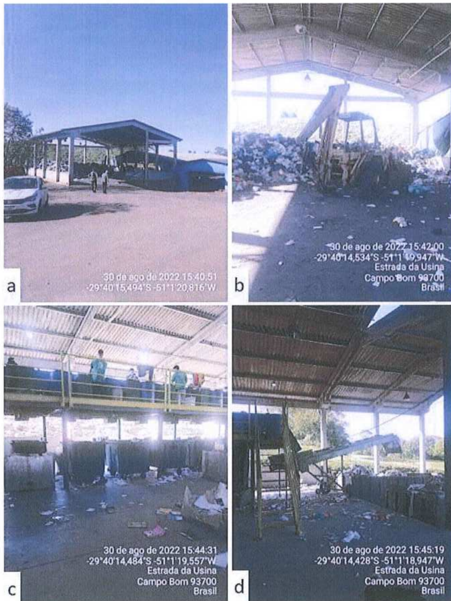
Figura 7 – Registros fotográficos da unidade de triagem e transbordo. a) Vista frontal do galpão; b) Vista do recebimento dos resíduos; c) Vista da esteira de seleção de resíduos; d) Vista da disposição dos resíduos nos contentores para transporte até o aterro sanitário.
