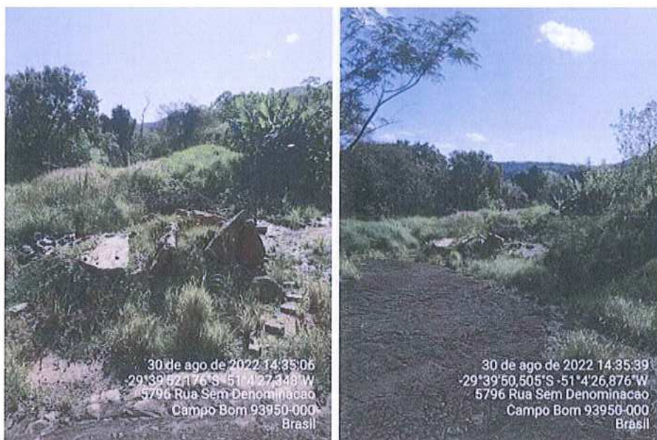
Figura 12 – Registro fotográfico do aterro de RCC com resíduos de pavimentação das obras da Corsan.
