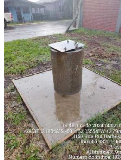
Poço junto ao R06
