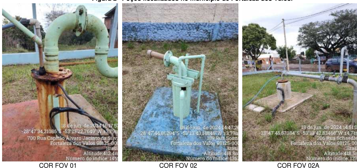
Figura 2– Poços fiscalizados no município de Fortaleza dos Valos.
