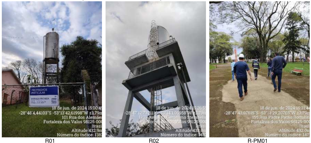
Figura 5 - Estruturas de reservação de Fortaleza dos Valos.
