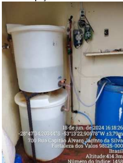
Figura 3 – Interior da casa de química simplificada do poço COR FOV 01
