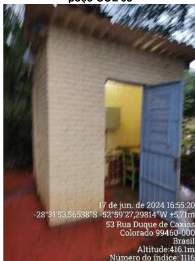
Figura 4 – Exterior da casa de química simplificada do poço COL 03
