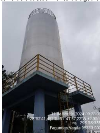
Figura 7 – Reservatório de abastecimento de água em Fagundes Varela.
