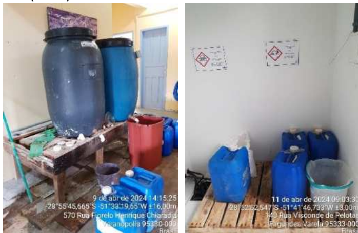
Figura 1 – Armazenamento dos produtos químicos empregados nos poços de Fagundes Varela em Veranópolis (esquerda) e Fagundes Varela (direita).
