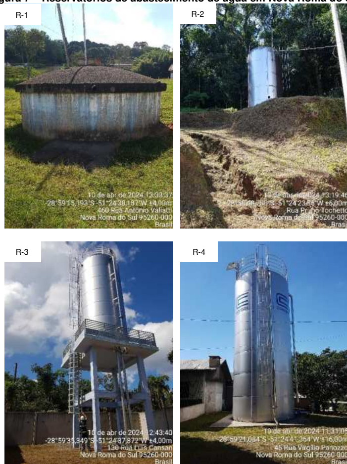
Figura 7 – Reservatórios de abastecimento de água em Nova Roma do Sul.
