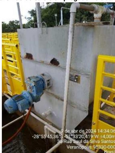
Figura 13 – Tanque de fluossilicato de sódio empregado no tratamento da água.
