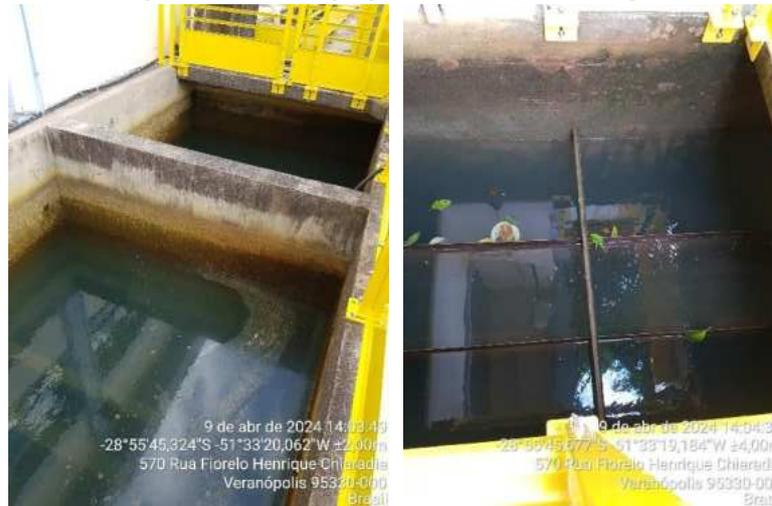
Figura 9 – Tanque de união de cloro e flúor empregado no tratamento da água.
