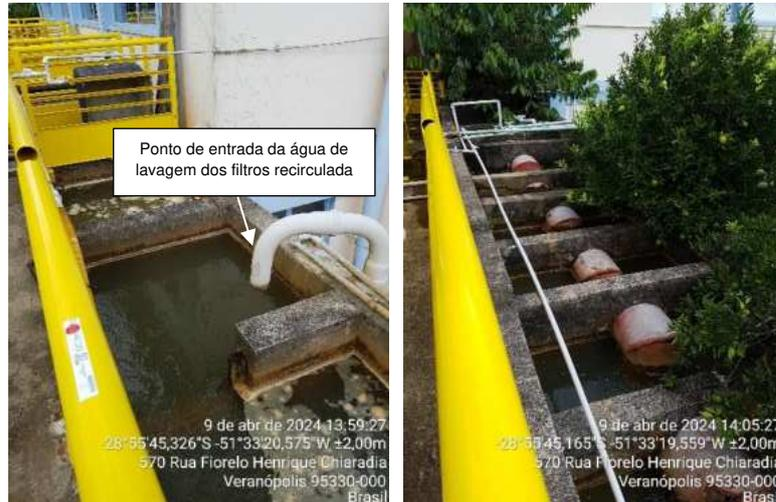
Figura 7 – Decantadores empregados no tratamento da água.
