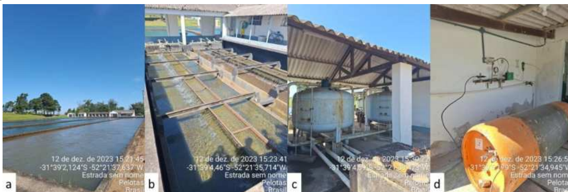
Figura 8: Registros fotográficos das estruturas da ETA: a) Decantador; b) Filtro Lento; c) Filtro Rápido; d) Cilindro de cloro.
