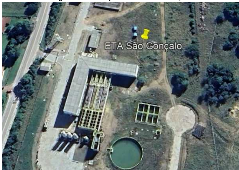
Figura 23: Vista superior da ETA São Gonçalo.
