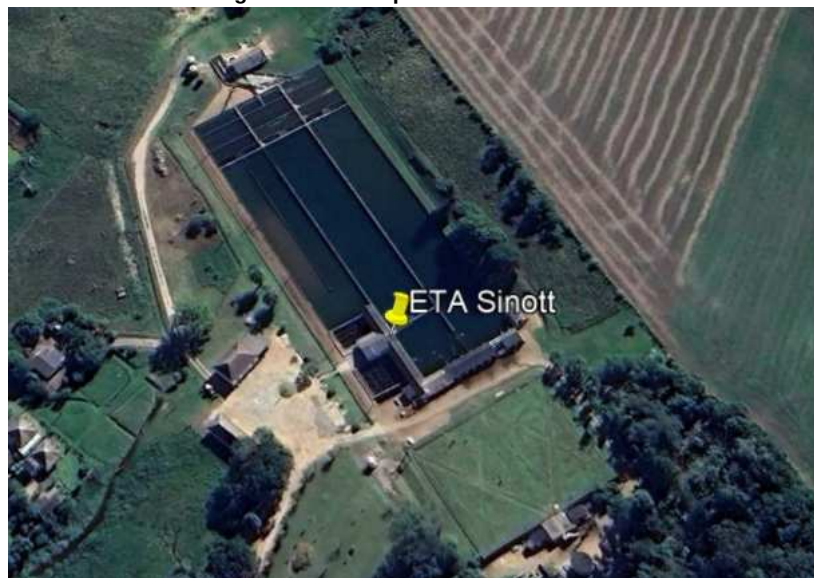
Figura 7: Vista superior da ETA Sinnott.
