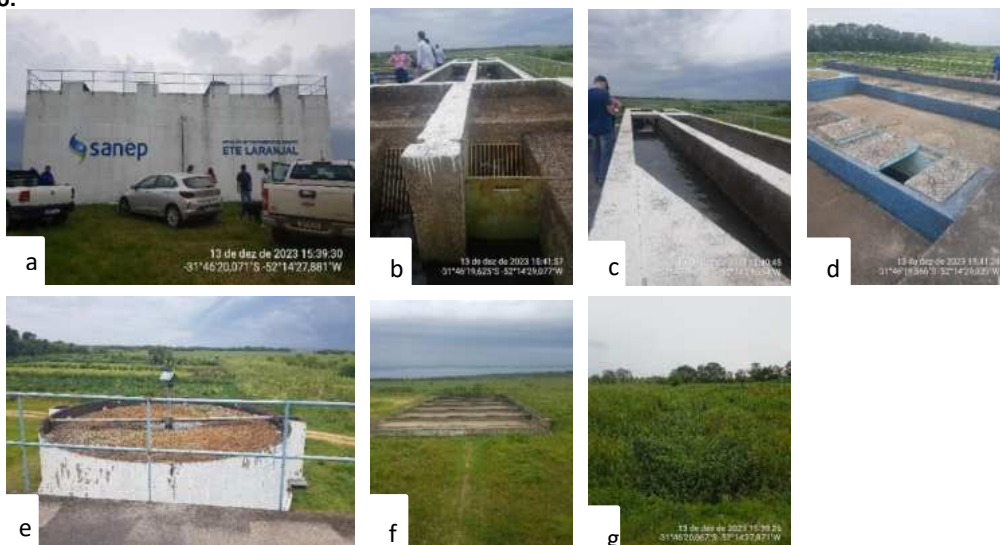
Figura 37: Registros fotográficos da ETE Laranjal: a) vista frontal da unidade; b) etapa preliminar do tratamento; c) calha Parshall; d) área do reator biológico; e) filtro biológico; f) leitos de secagem do logo; g) vista frontal da lagoa de estabilização.
