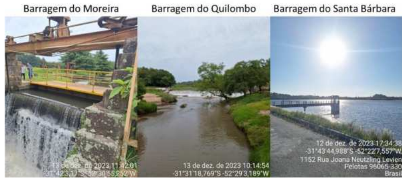
Figura 4: Captações de água bruta vistoriadas em Pelotas.
