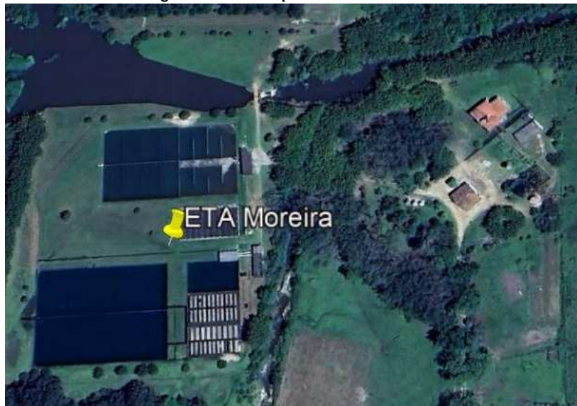
Figura 17: Vista superior da ETA Moreira.
