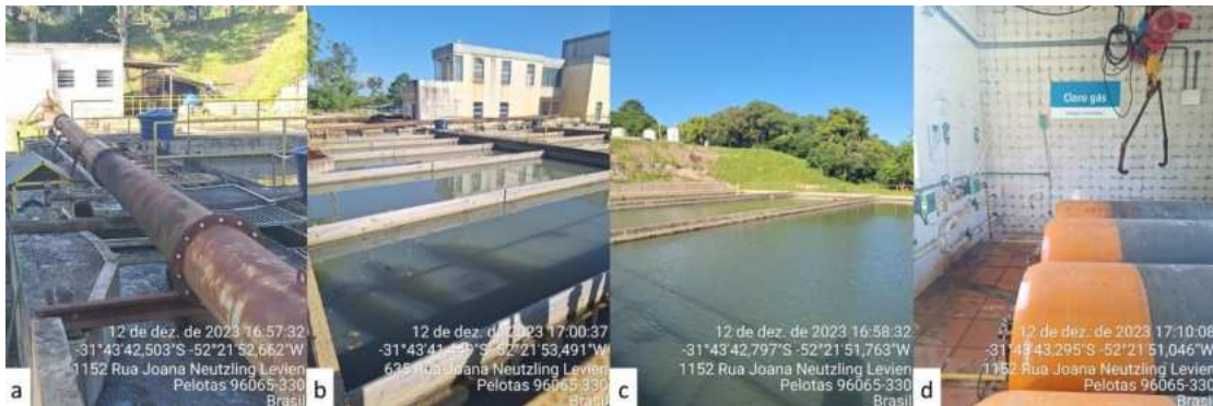
Figura 11: Registros fotográficos das estruturas da ETA: a) Chegada de Água Bruta; b) Floculador; c) Decantador; d) Cilindros de cloro.
