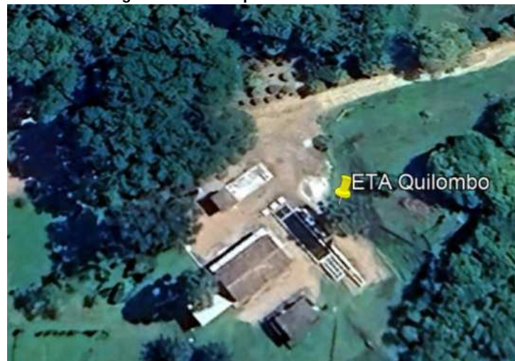
Figura 14: Vista superior da ETA Quilombo.
