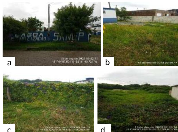
Figura 33: Registros fotográficos da ETE Rodoviária: a) Entrada da unidade ETE Rodoviária; b) Interior da área da unidade; c) Gradil de proteção da lagoa de estabilização; d) Lagoa de estabilização.
