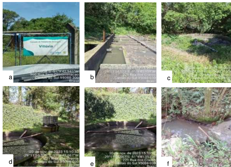
Figura 2: Registro Fotográfico da ETE Vitória. a) Placa de identificação da unidade; b) Calha Parshall e reator. c) Filtro biológico e vegetação acumulada; d) vista superior da área do filtro; e) vista lateral da área do filtro; f) emissão no corpo receptor.
