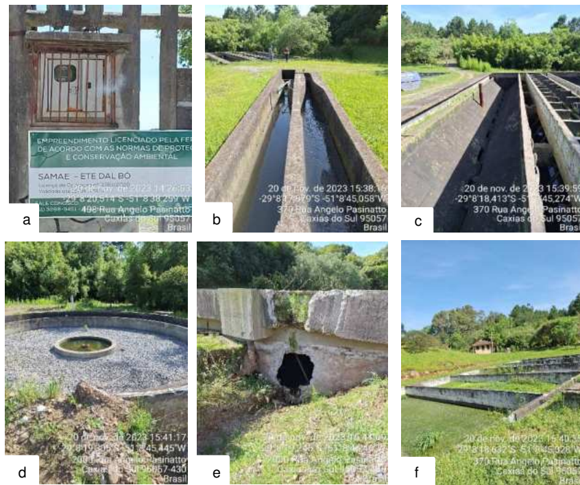
Figura 2: Registro Fotográfico da ETE Vitória. a) Placa de identificação da unidade; b) Calha Parshall e reator. c) Filtro biológico e vegetação acumulada; d) vista superior da área do filtro; e) vista lateral da área do filtro; f) emissão no corpo receptor.
