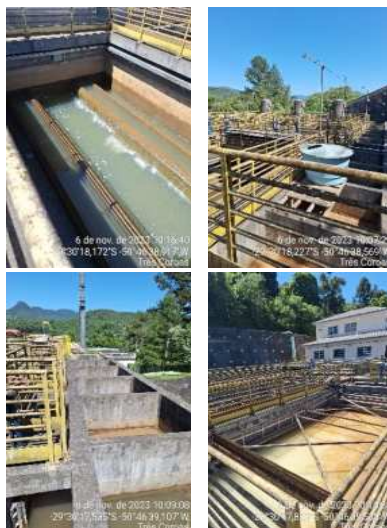
Figura 1: Estruturas do novo bloco de tratamento da ETA de Três Coroas
