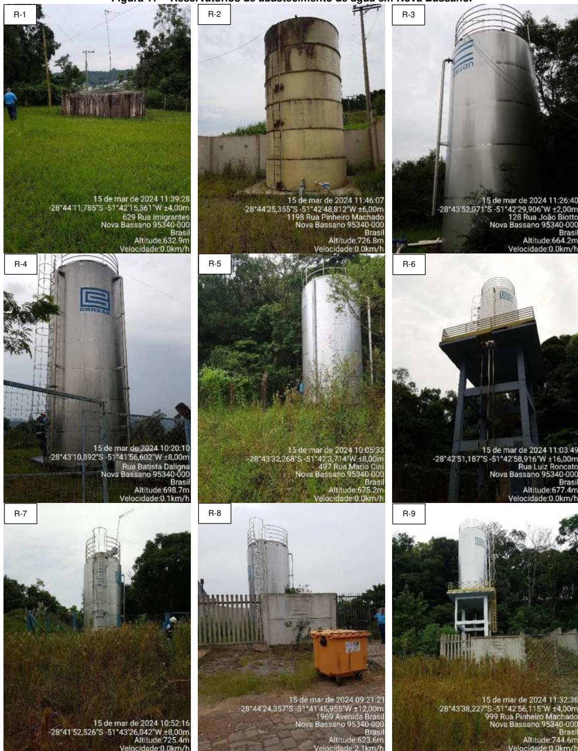
Figura 17 – Reservatórios de abastecimento de água em Nova Bassano.
