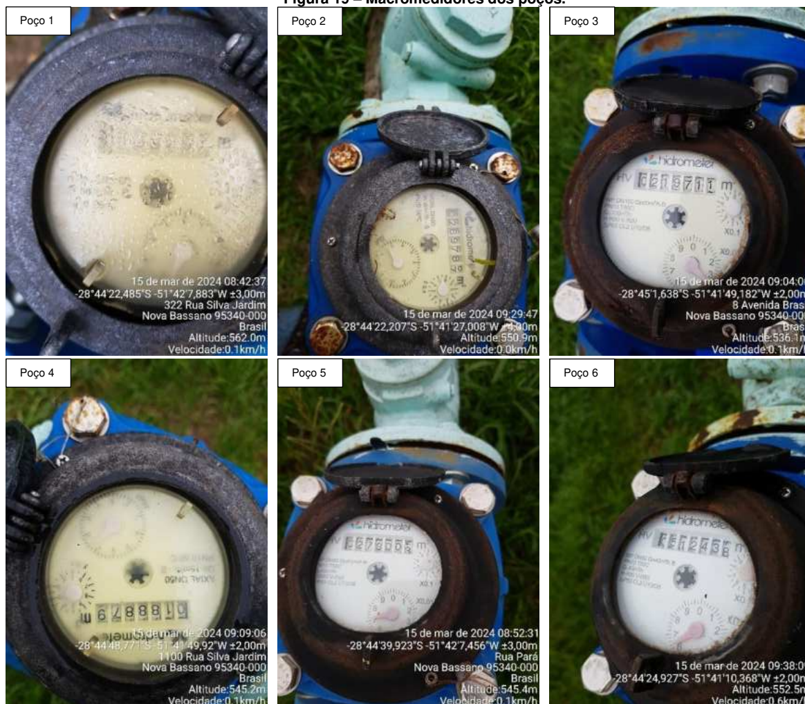
Figura 19 – Macromedidores dos poços.
