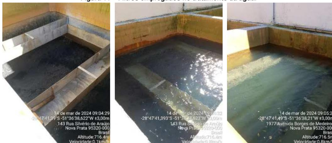
Figura 12 – Câmara de contato de cloro e flúor empregado no tratamento da água.
