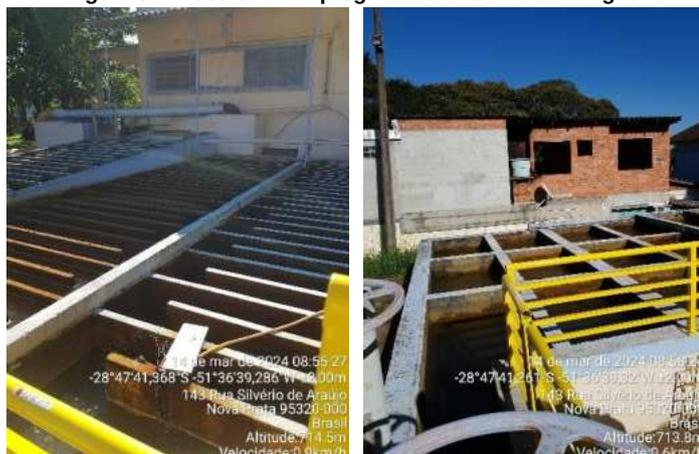
Figura 10 – Decantadores empregados no tratamento da água.
