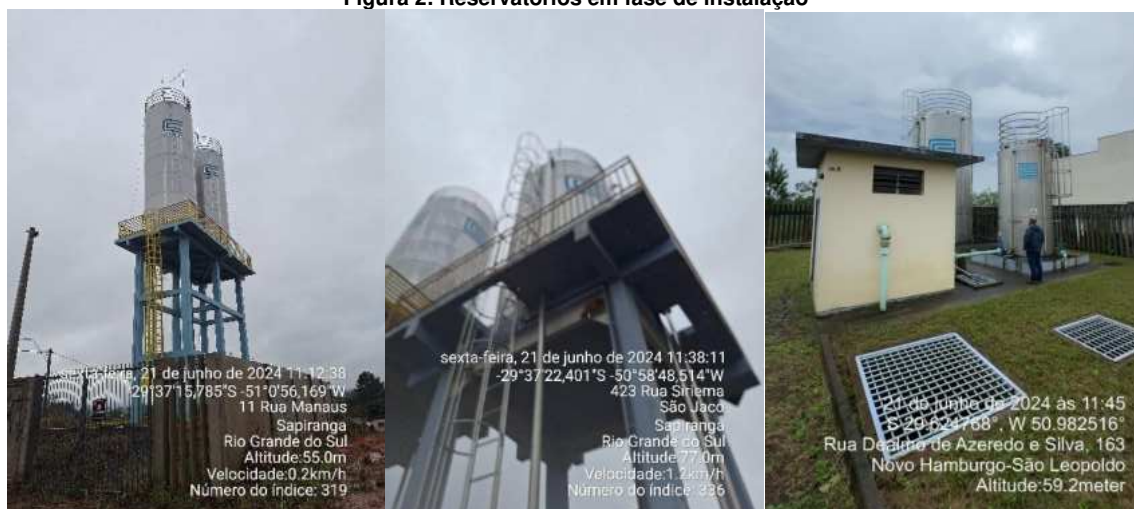
Figura 2: Reservatórios em fase de instalação
