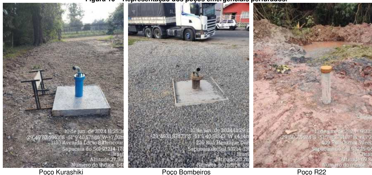
Figura 16 – Representação dos poços emergenciais perfurados.
