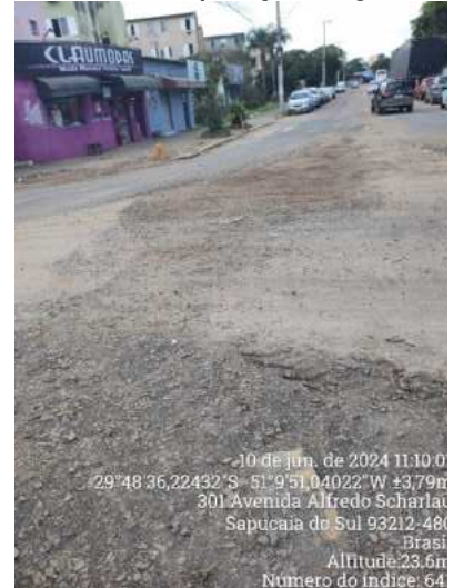
Figura 10 – Registro de chegada da adutora de importação de água.
