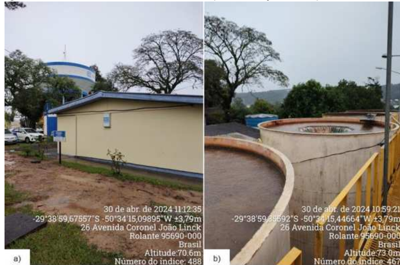
Figura 3 – Estrutura da ETA em Rolante: a) casa de química; b) bloco hidráulico.
