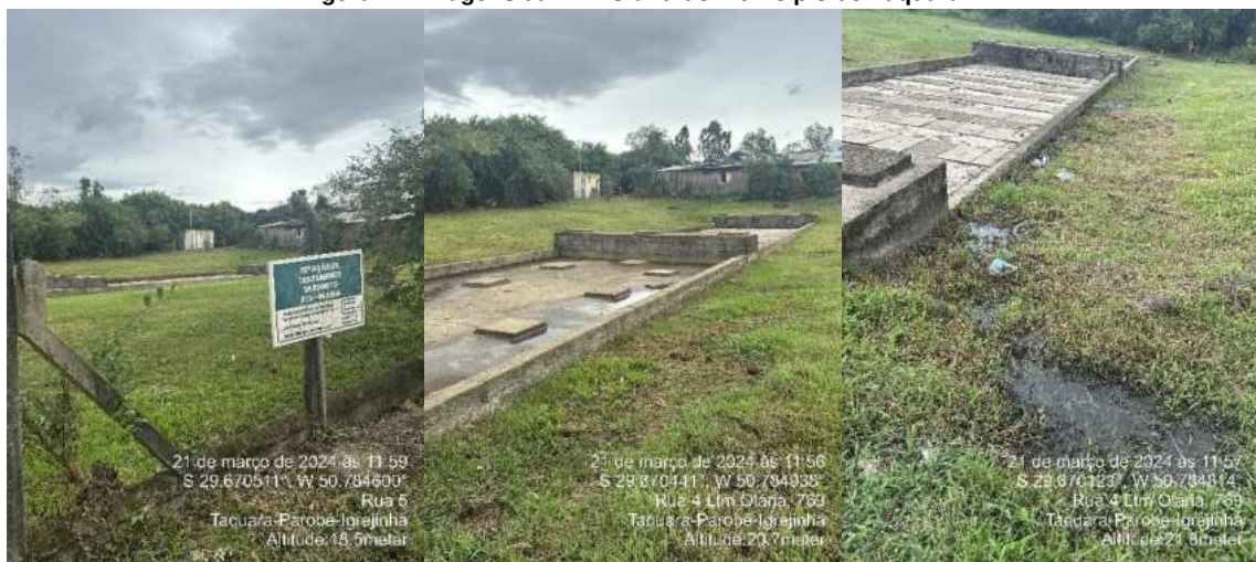
Figura 14: Imagens da ETE Olaria do município de Taquara.
