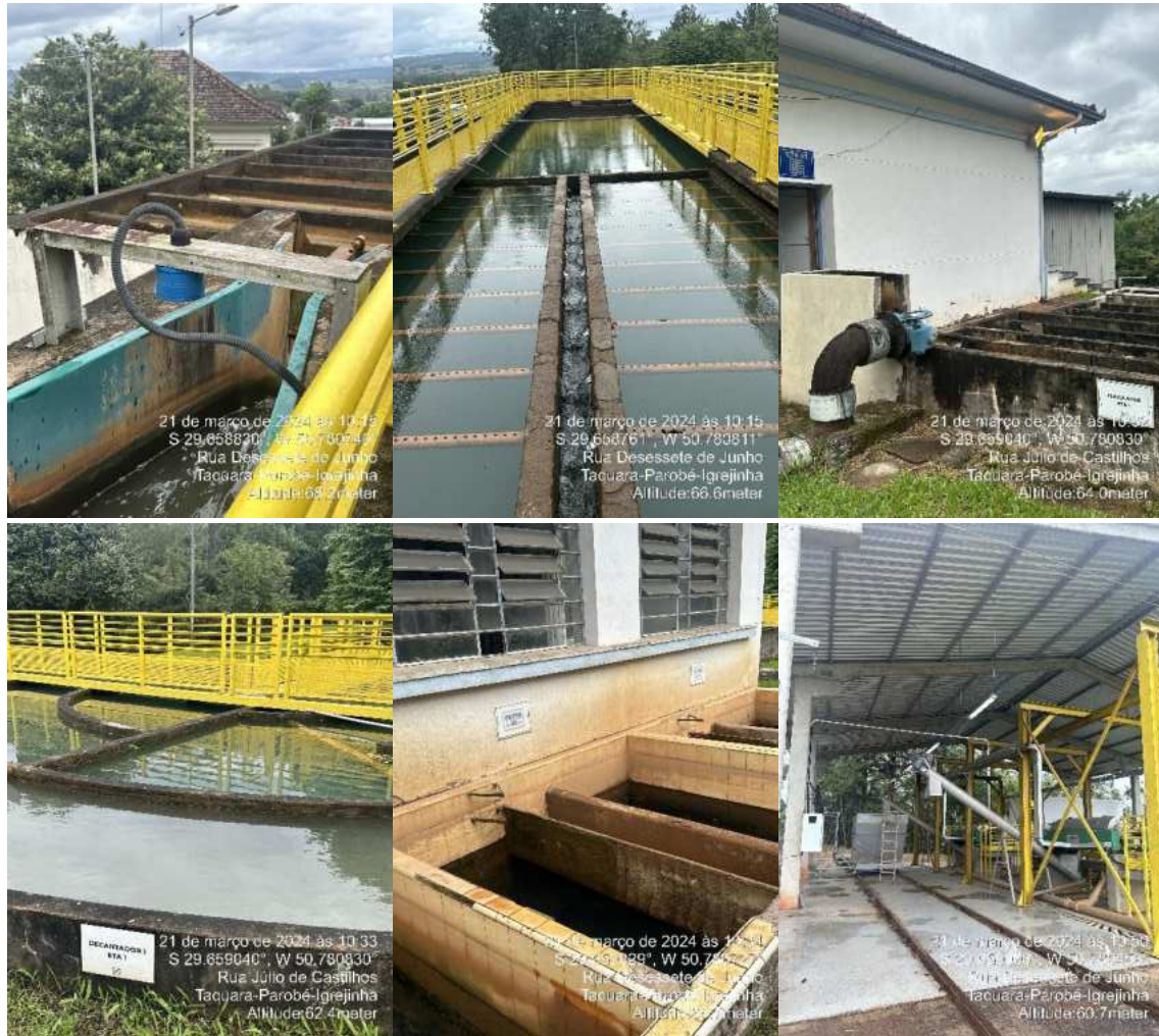
Figura 5: Registros fotográficos das estruturas da ETA.
