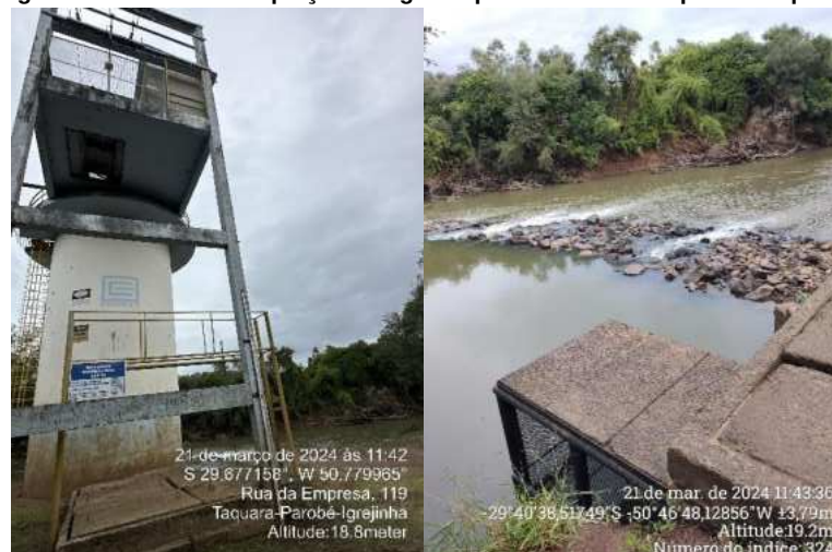
Figura 3: Estrutura da captação de água superficial do município de Taquara.
