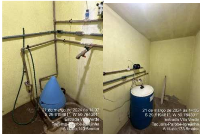
Figura 8: Registros fotográficos da estrutura do poço
