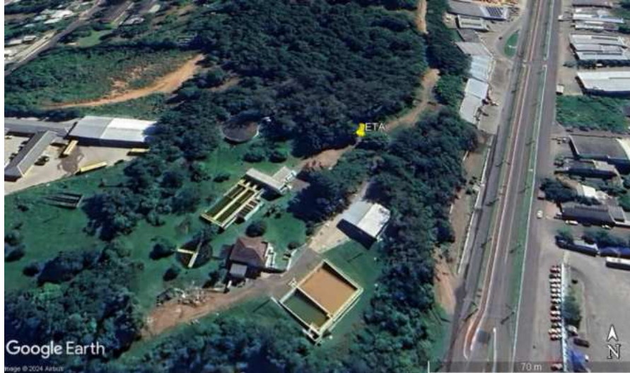
Figura 4: Localização da ETA de Taquara.
