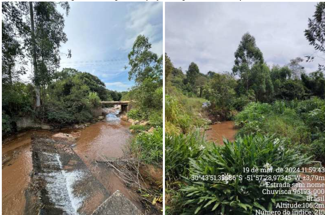
Figura 1 – Barragem de captação de água do Arroio Joaquim Martim.
