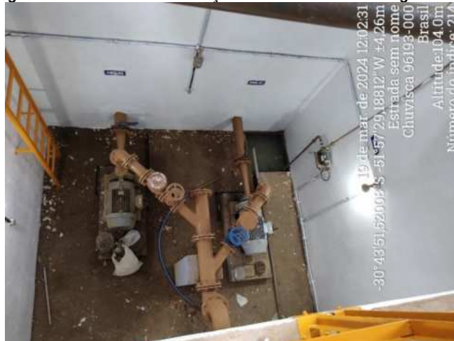
Figura 4 – Área interna da estação de bombeamento de água bruta.
