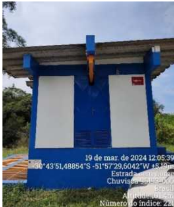
Figura 8 – Estação de bombeamento de água bruta (EBA 01)
