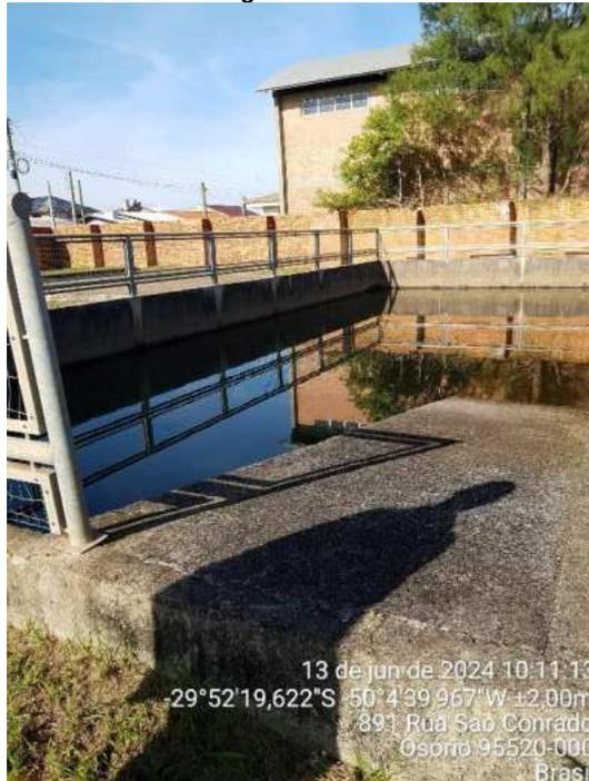
Figura 18 – Tanque de recirculação de água de lavagem da ETA II Atlântida Sul.
