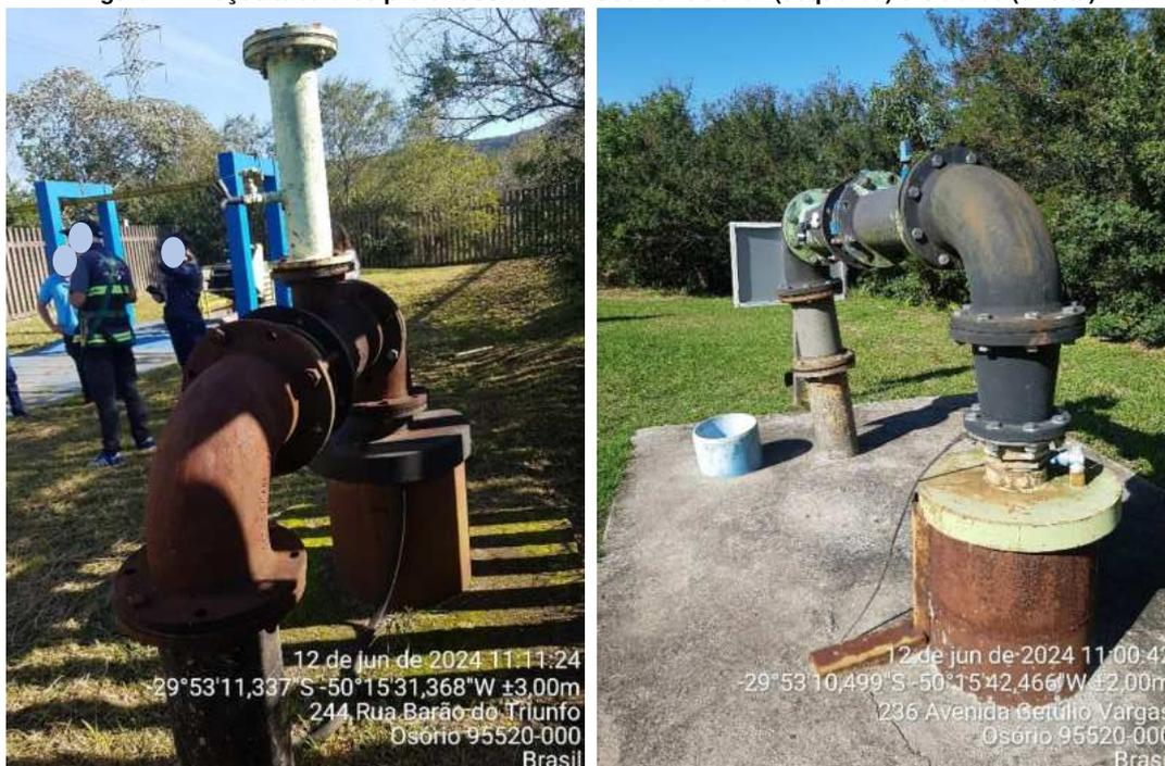
Figura 3 – Poços tubulares profundos novos perfurados em Osório: R04 (esquerda) e EBAT Tombadouro (direita).
