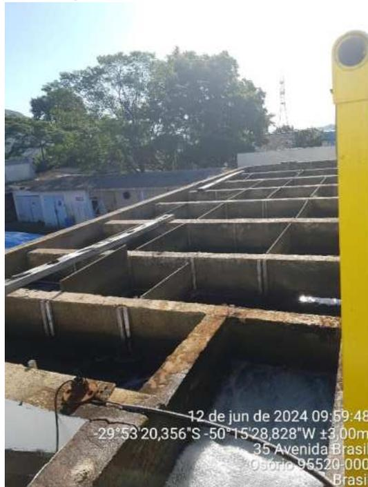
Figura 7 – Decantadores da ETA Osório.
