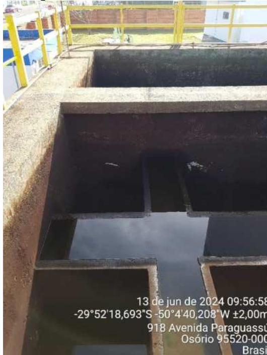
Figura 17 – Leito de secagem do lodo da ETA II Atlântida Sul.
