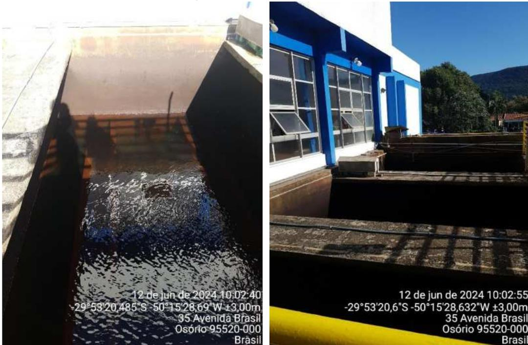
Figura 9 – Câmara de mistura de flúor da ETA Osório.
