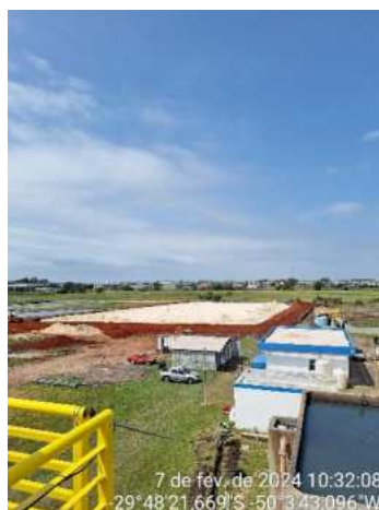
Figura 6: Bacia n.7 em construção na parte leste da área da ETE – II que compõe o SES de Xangri-Lá.
