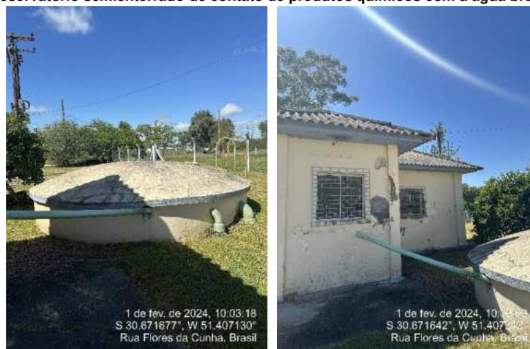
Figura 8 – Reservatório semienterrado de contato de produtos químicos com a água bruta dos poços.
