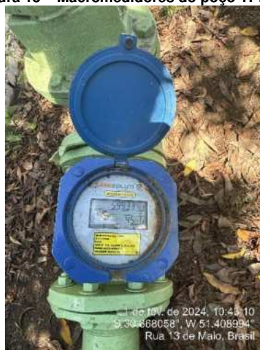
Figura 13 – Macromedidores do poço TPE-9B.
