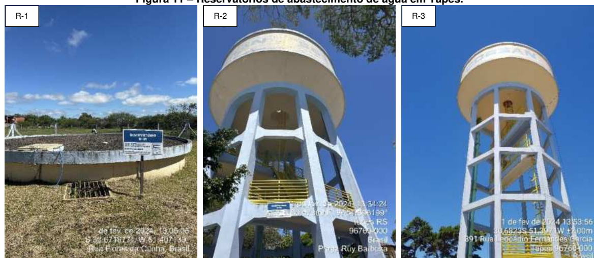
Figura 11 – Reservatórios de abastecimento de água em Tapes.
