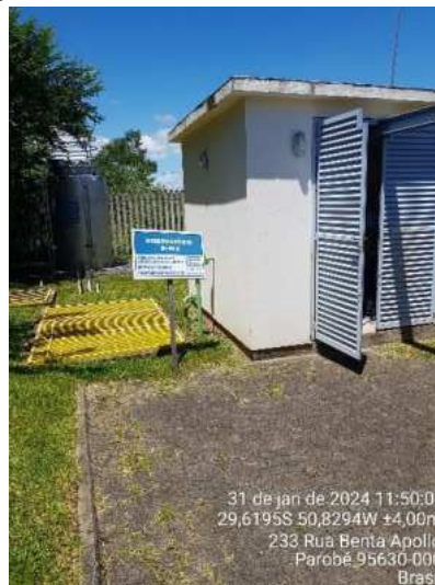
Figura 4: EBA 10 e reservatório R10A.
