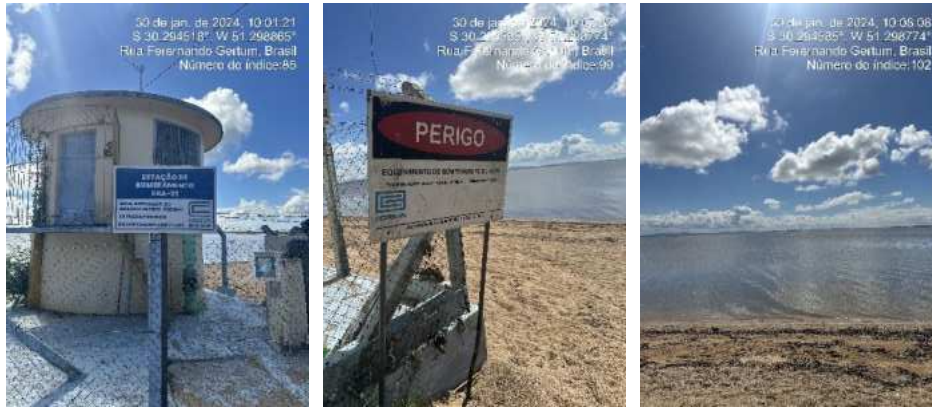
Figura 2: Captação superficial no município de Barra do Ribeiro.
