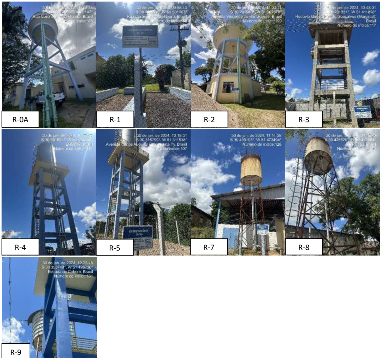
Figura 9: Registros fotográficos dos reservatórios fiscalizados em Barra do Ribeiro.
