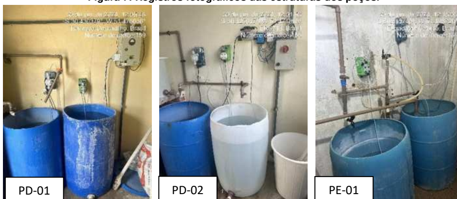
Figura 7: Registros fotográficos das estruturas dos poços.
