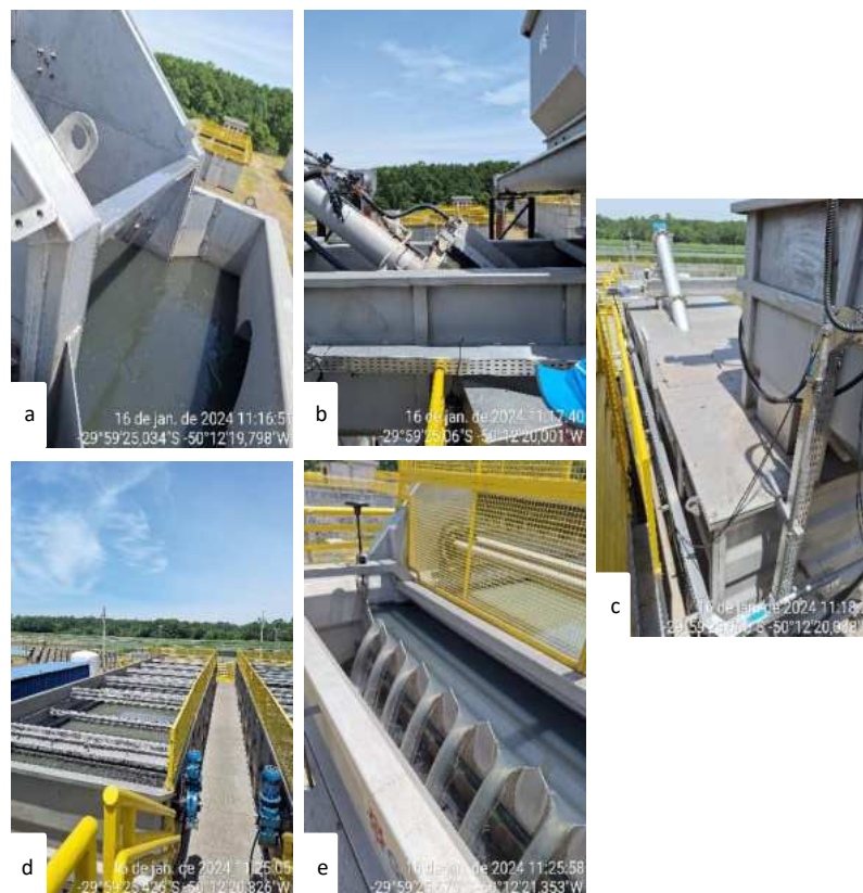
Figura 8 – Registro fotográfico da obra ETE Compacta. a) Chegada do efluente e gradeamento; b) desarenador; c) misturador; d) Floculadores; e) saída do Floculador para desinfecção.
