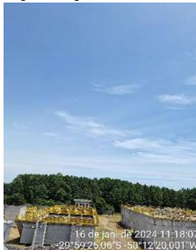
Figura 7 – Registro fotográfico da obra ETE Convencional.
