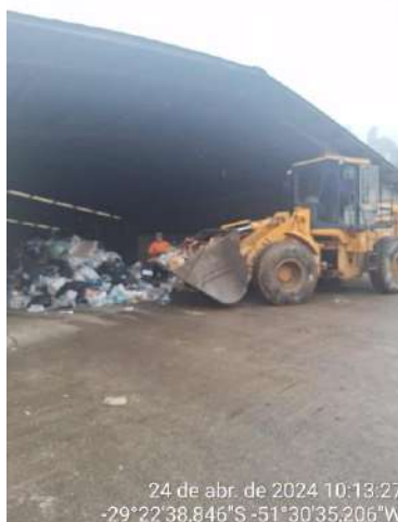
Figura 07: Unidade de Transbordo de resíduos de Carlos Barbosa.
