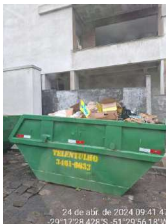
Figura 12: Contentor de entulho em Carlos Barbosa.
