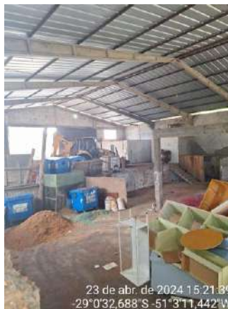
Figura 06: Área anexa da Unidade de Transbordo de São Marcos.
