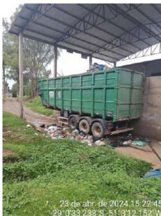
Figura 04: Unidade de Transbordo de RSU em São Marcos.
