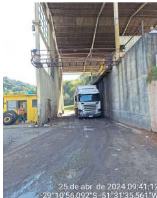
Figura 07: Unidade de Transbordo de resíduos de Bento Gonçalves.
