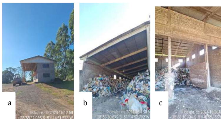
Figura 05: Estação de Transbordo do SMRSU de Flores da Cunha. a) Balança de pesagem de veículos; b) Área de descarga de resíduos; c) Área de rejeitos e enlonaamento do veículo transportador para destinação final.
