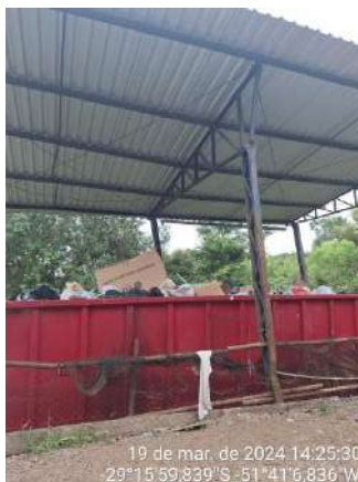
Figura 03: Estação de Transbordo de RSU de Coronel Pilar/RS
