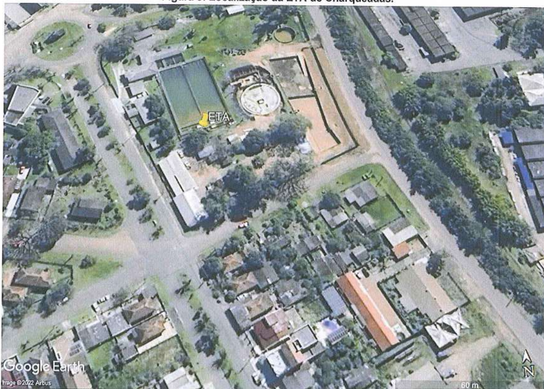
Figura 8: Localização da ETA de Charqueadas.
