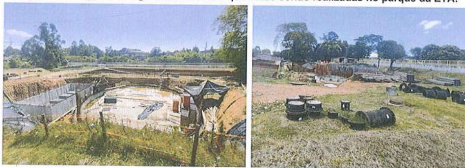
Figura 12: Registro fotográfico das obras que estão sendo realizadas no parque da ETA.
