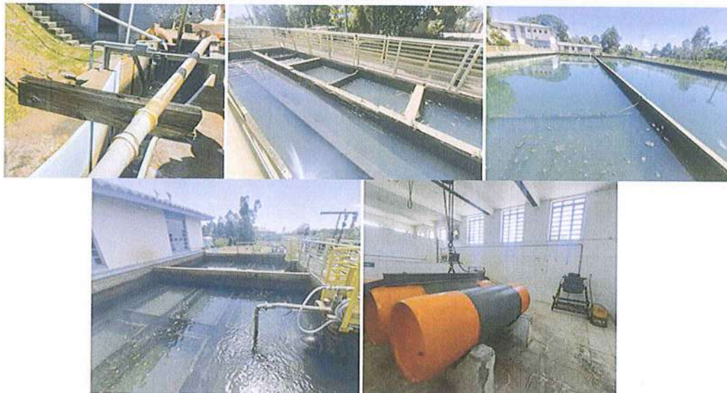
Figura 9: Registros fotográficos das estruturas da ETA.
