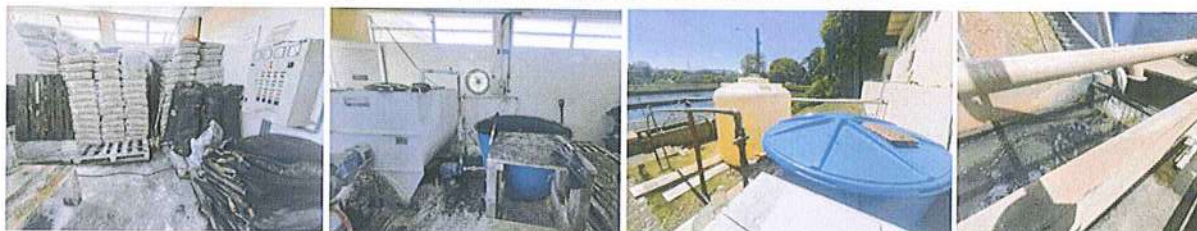
Figura 10: Registros fotográficos das estruturas da ETA.
