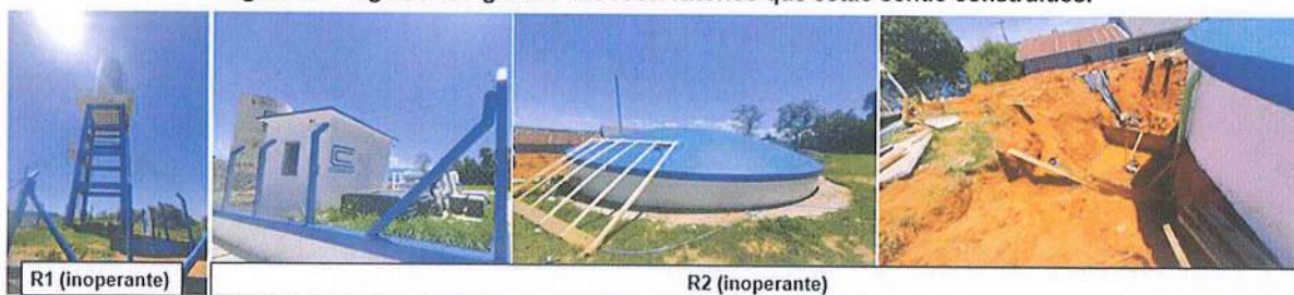
Figura 12: Registro fotográfico dos reservatórios que estão sendo construídos.
