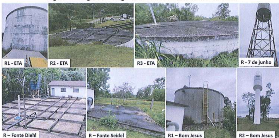
Figura 19: Registros fotográficos dos reservatórios fiscalizados.
