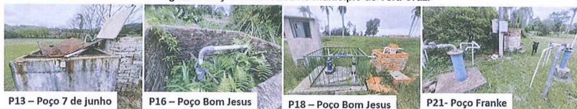
Figura 9: Poços vistoriados no município de Vera Cruz.
