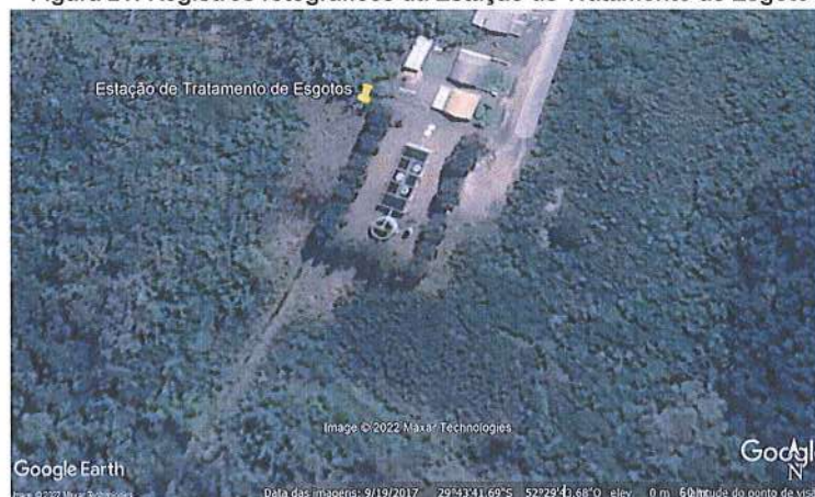
Figura 21: Registros fotográficos da Estação de Tratamento de Esgoto
