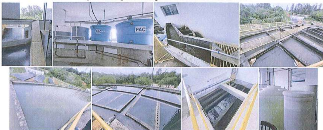
Figura 13: Registros fotográficos das estruturas da ETA.
