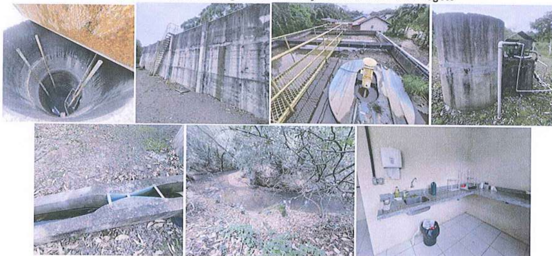
Figura 22: Registros fotográficos da Estação de Tratamento de Esgoto
