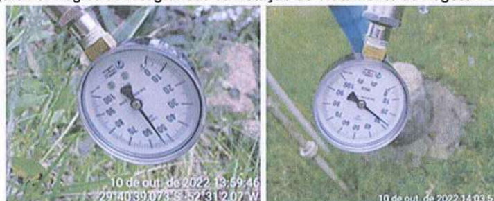
Figura 20: Registros fotográficos da Estação de Tratamento de Esgoto Central
