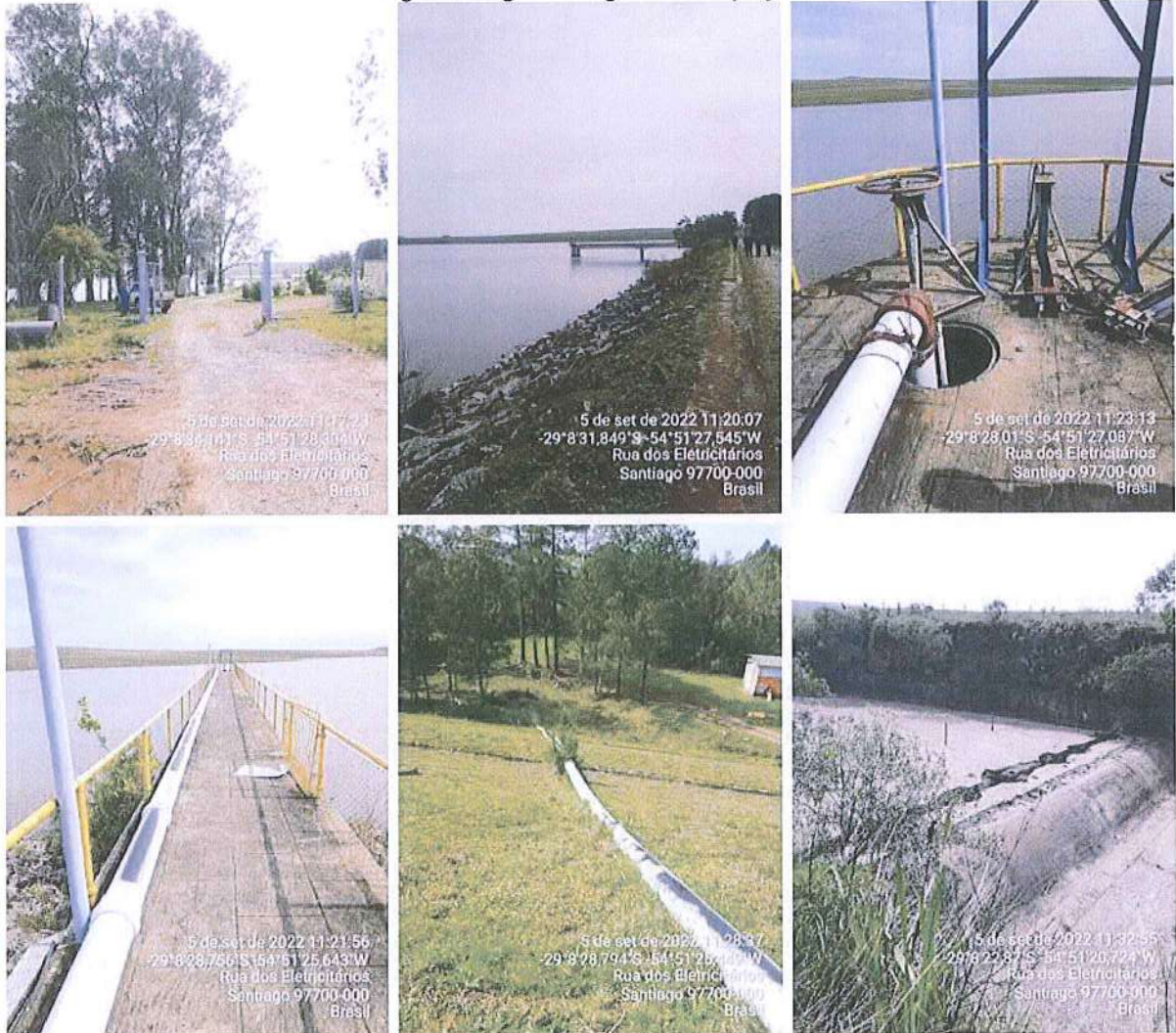
Figura 5: Registro fotográfico da captação
