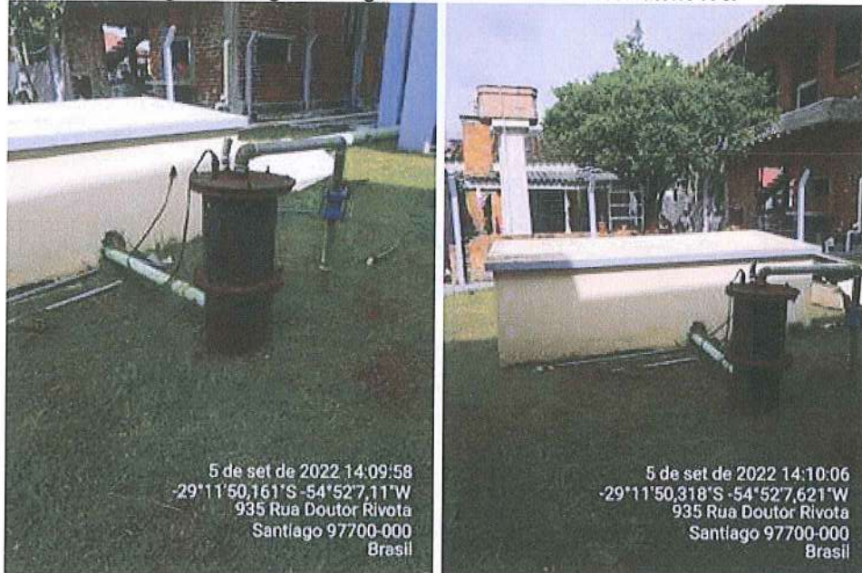
Figura 16: Registro fotográfico da elevatória do reservatório R-5.
