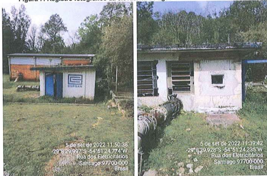
Figura 7: Registro fotográfico da elevatória de água bruta desativada
