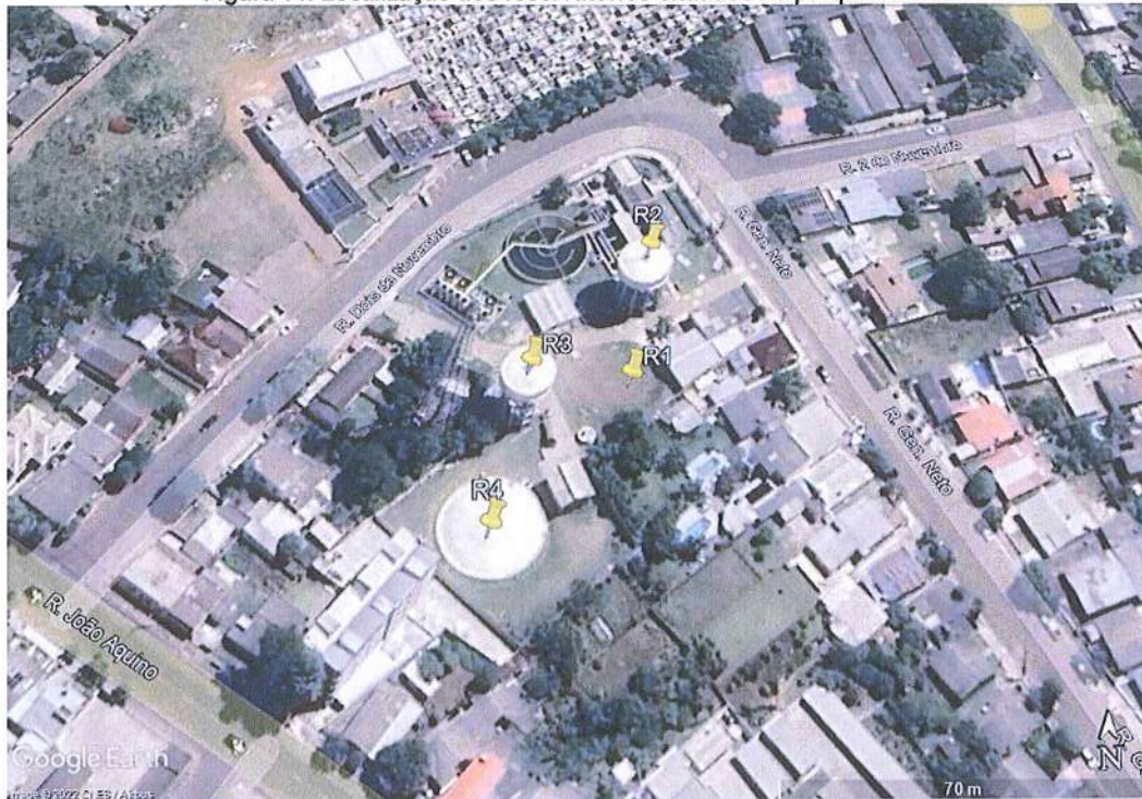
Figura 14: Localização dos reservatórios situados no parque da ETA
