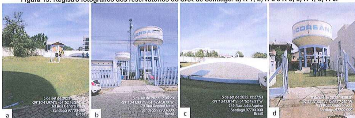
Figura 15: Registro fotográfico dos reservatórios do SAA de Santiago: a) R-1; b) R-2 e R-3; c) R-4; d) R-5.
