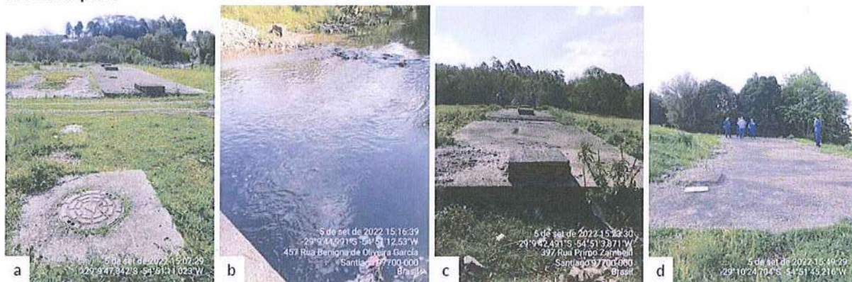
Figura 21: Registro fotográfico dos TSC de Santiago: a) TSC Ana Bonato 1; b) Vista do corpo receptor à jusante ao ponto de lançamento do efluente com indícios da presença de matéria orgânica no local; c) TSC Ana Bonato 2; TSC Jardim dos Eucaliptos.
