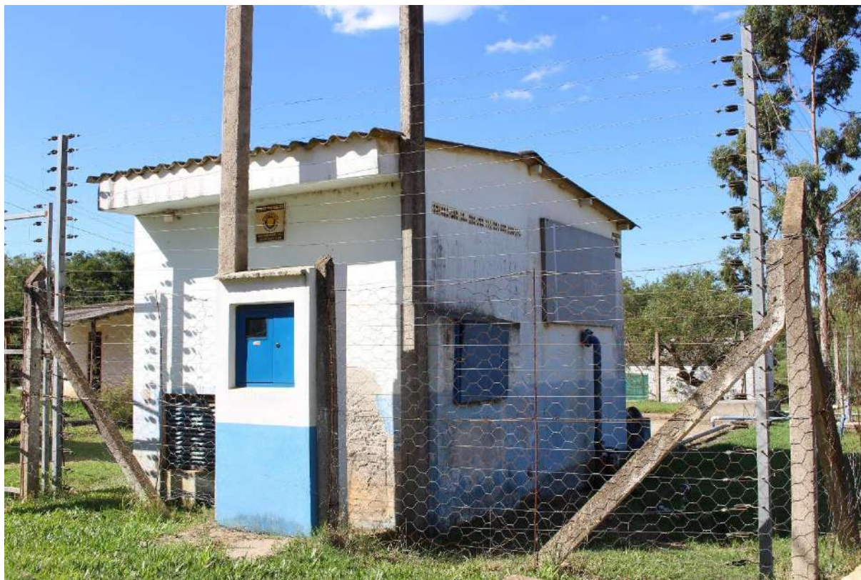
Figura 49 – Reservatório apoiado/poço Tiarajú
