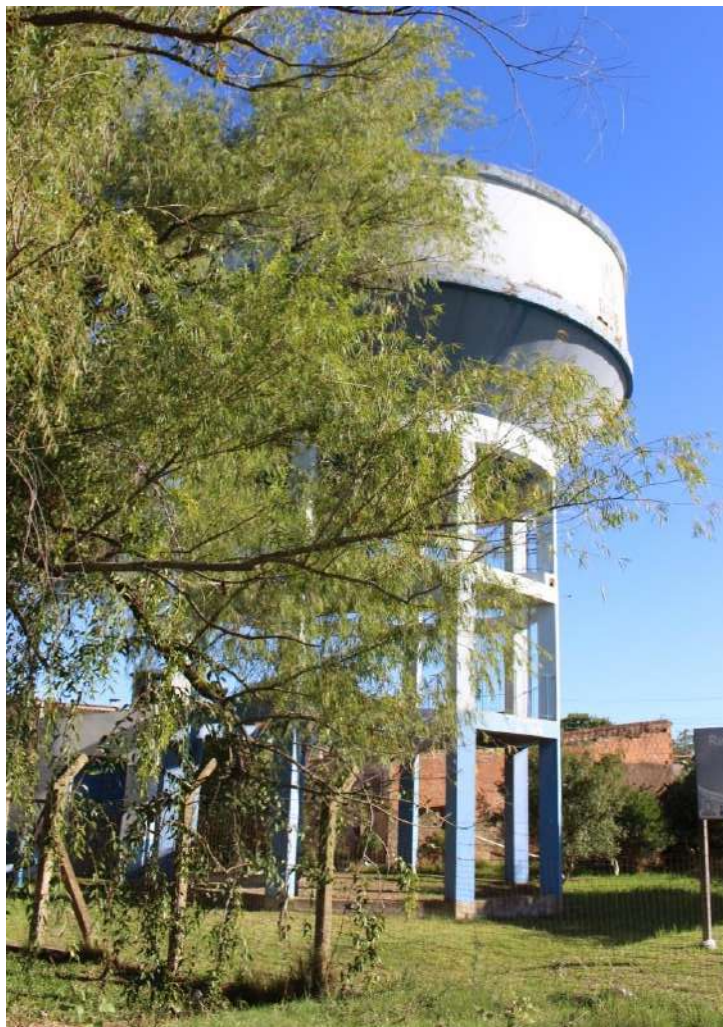
Figura 39 – Reservatório elevado Vila Militar
