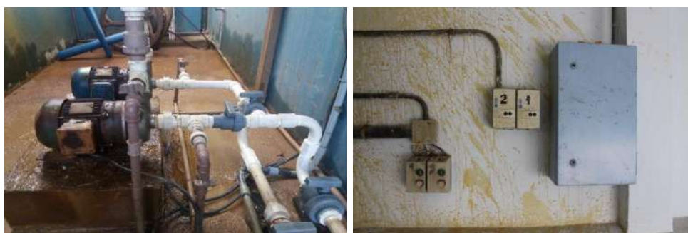
Figura 8 - Bombas de Sulfato
