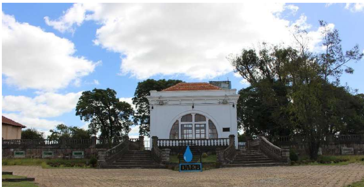
Figura 16 - Reservatório de água tratada
