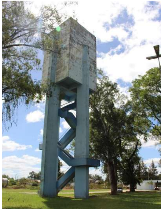
Figura 20 - Reservatório Elevado ETA
