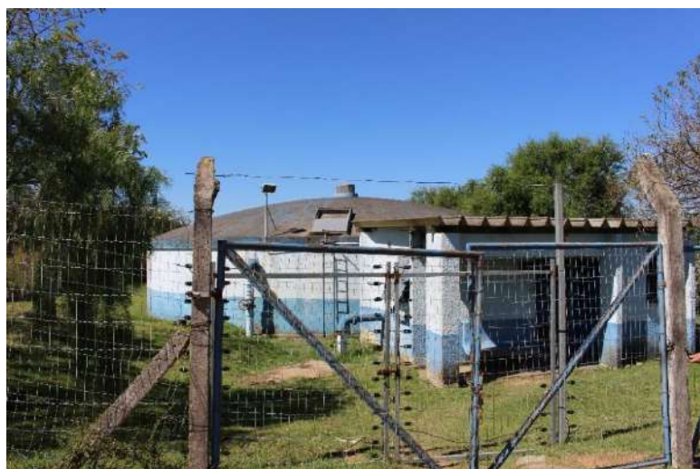
Figura 29 - Reservatório apoiado São Martins
