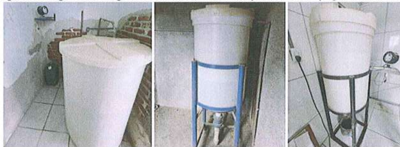
Figura 6: Registros fotográficos do tratamento simplificado dos poços vistoriados.
