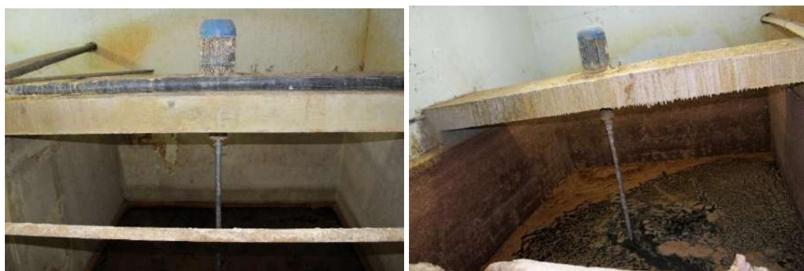
Figura 9 - Tinas de sulfato
