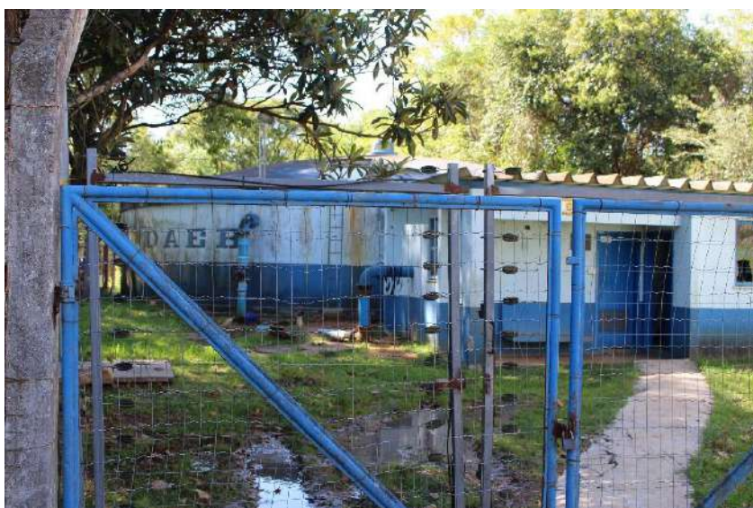
Figura 33 - Reservatório apoiado São João
