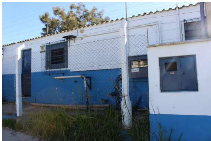
Figura 25 - Reservatório apoiado Stand
