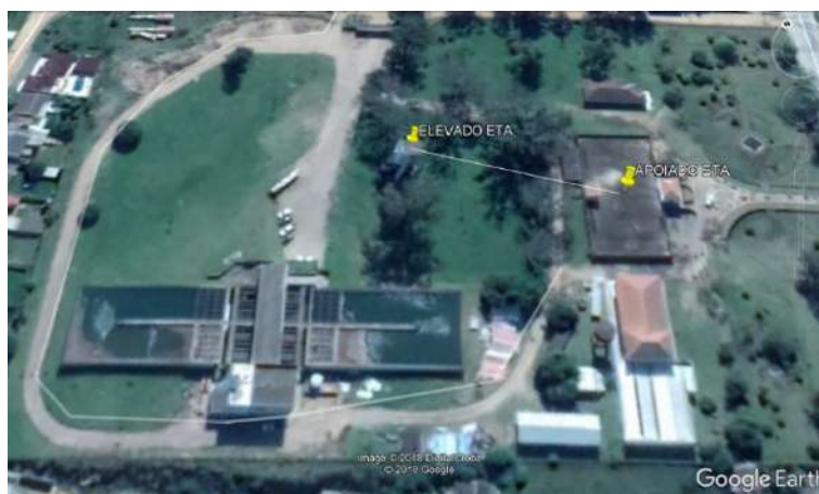
Figura 19 – Caminho apoiado - elevado ETA
