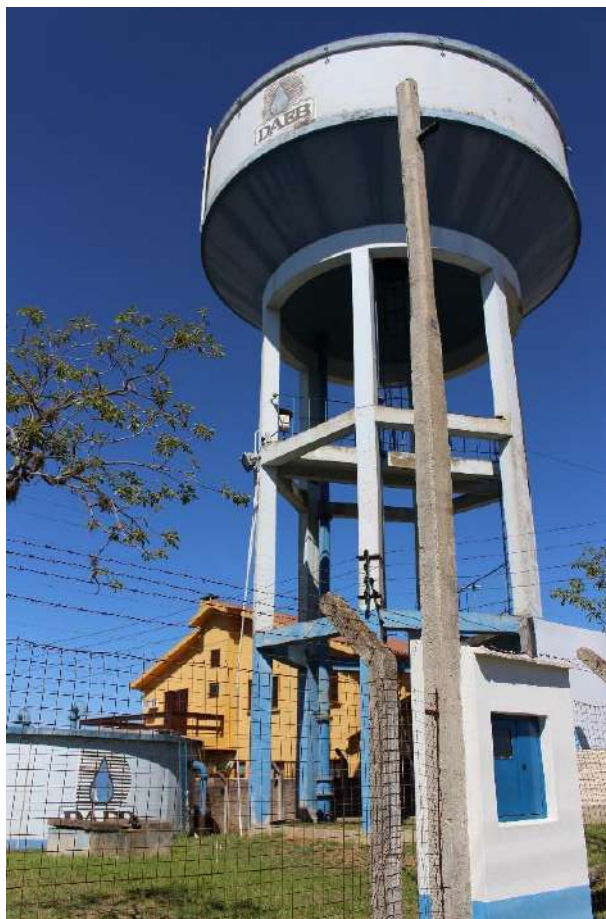
Figura 44 – Reservatório elevado Laranjeiras
