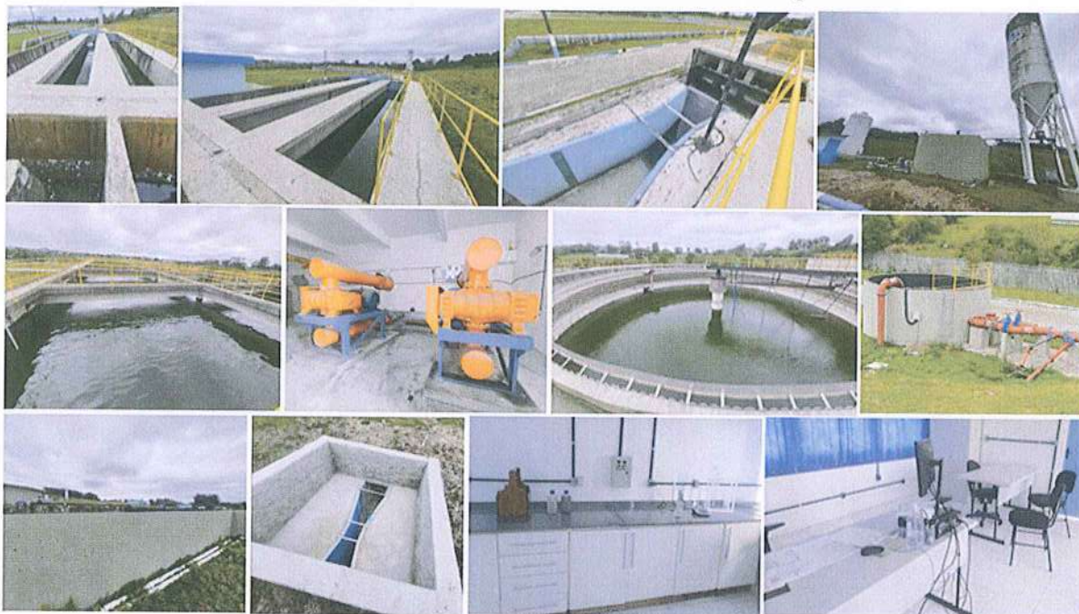
Figura 10: Registros fotográficos da Estação de Tratamento de Esgoto Central.
