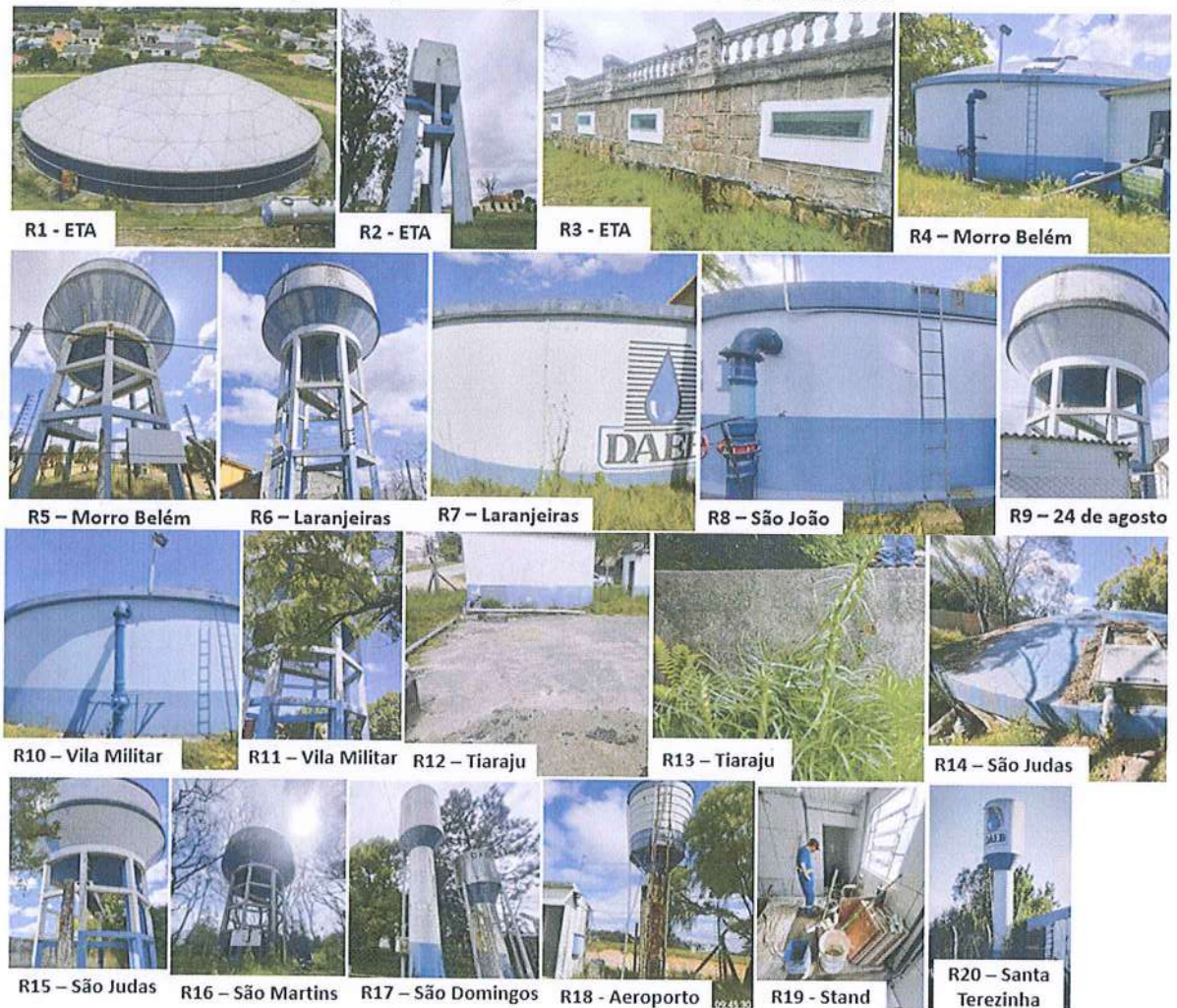
Figura 7: Registros fotográficos dos reservatórios fiscalizados.
