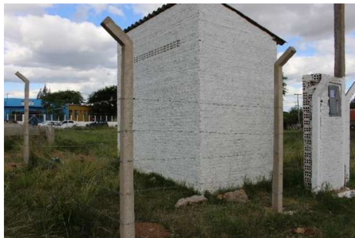
Figura 68 –Poço Castro Alves
