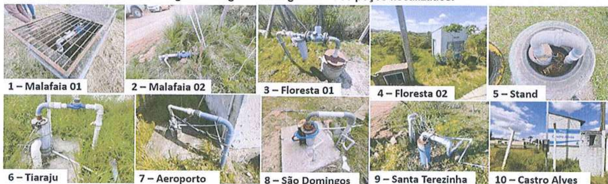
Figura 2: Registros fotográficos dos poços fiscalizados.
