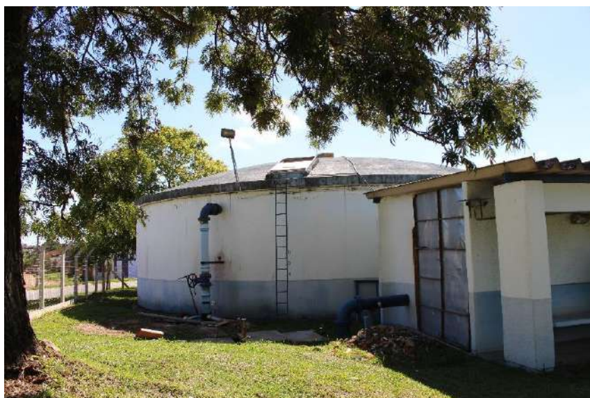
Figura 46 - Reservatório apoiado Morro Belém
