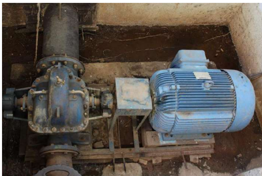
Figura 4 - Bomba Worthington 8LN14 Fonte: Autor, 2020.
