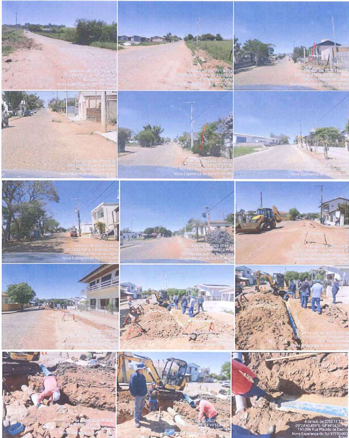
Figura 7: Obras na rua Plácido de Castro.
