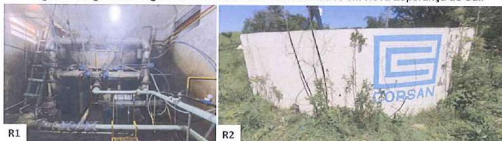
Figura 5: Registros fotográficos dos reservatórios fiscalizados em Nova Esperança do Sul.
