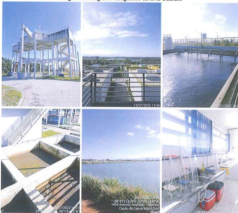
Figura 20: Registro fotográfico da ETE Guarani
