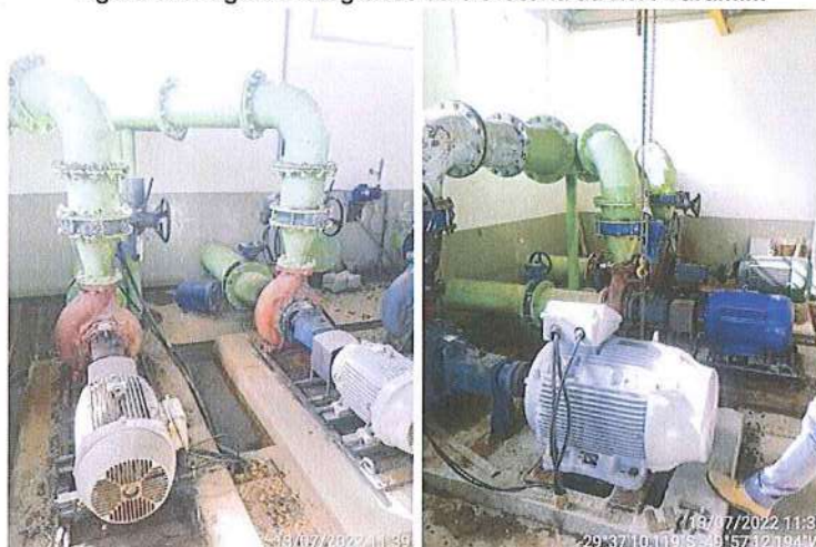
Figura 13: Registro fotográfico da elevatória da ETA Curumim
