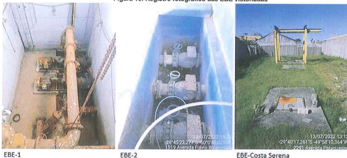
Figura 16: Registro fotográfico das EBE vistoriadas
