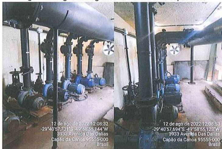
Figura 14: Registro fotográfico da elevatória de Capão Novo
