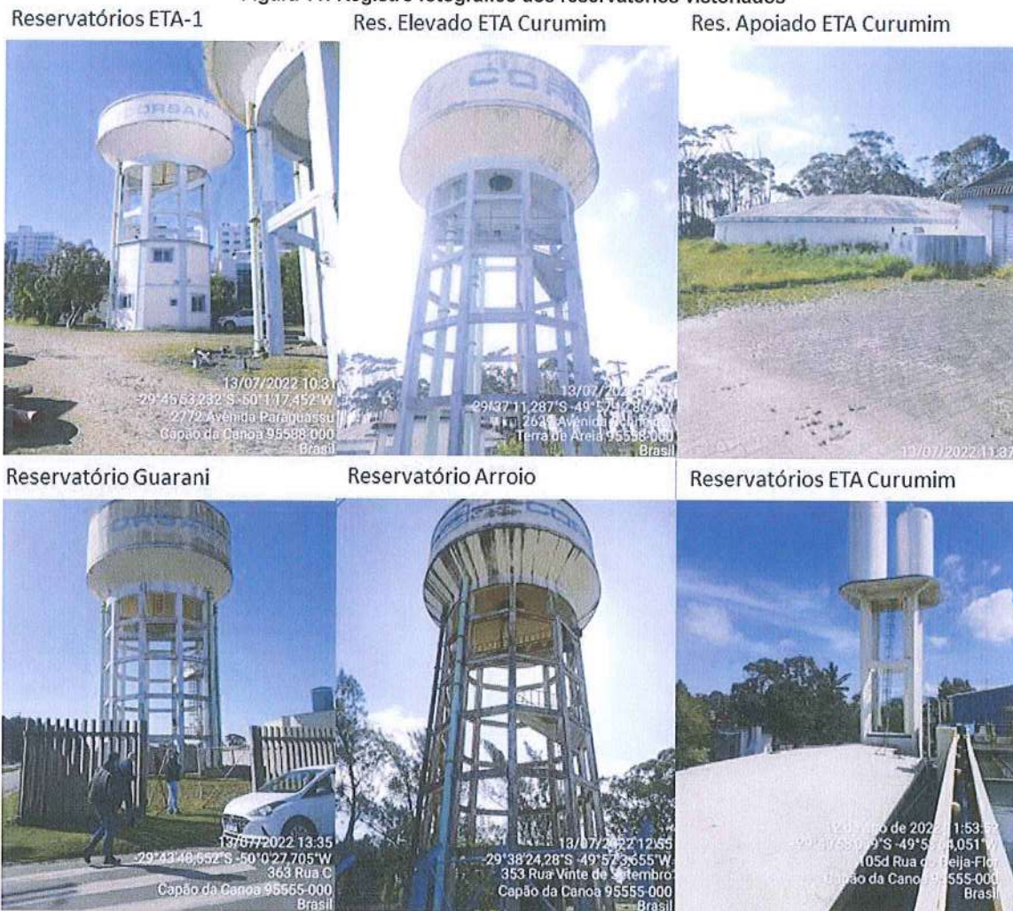
Figura 11: Registro fotográfico dos reservatórios vistoriados
