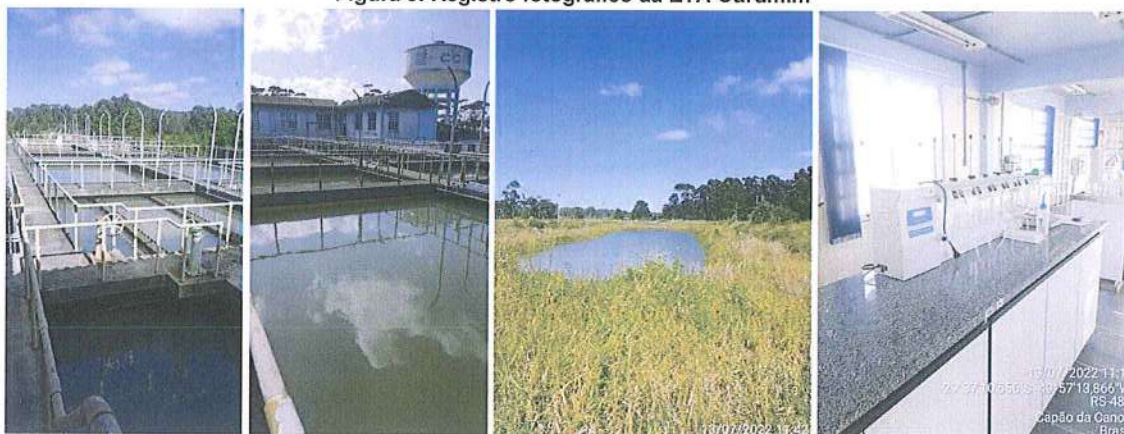
Figura 8: Registro fotográfico da ETA Curumim
