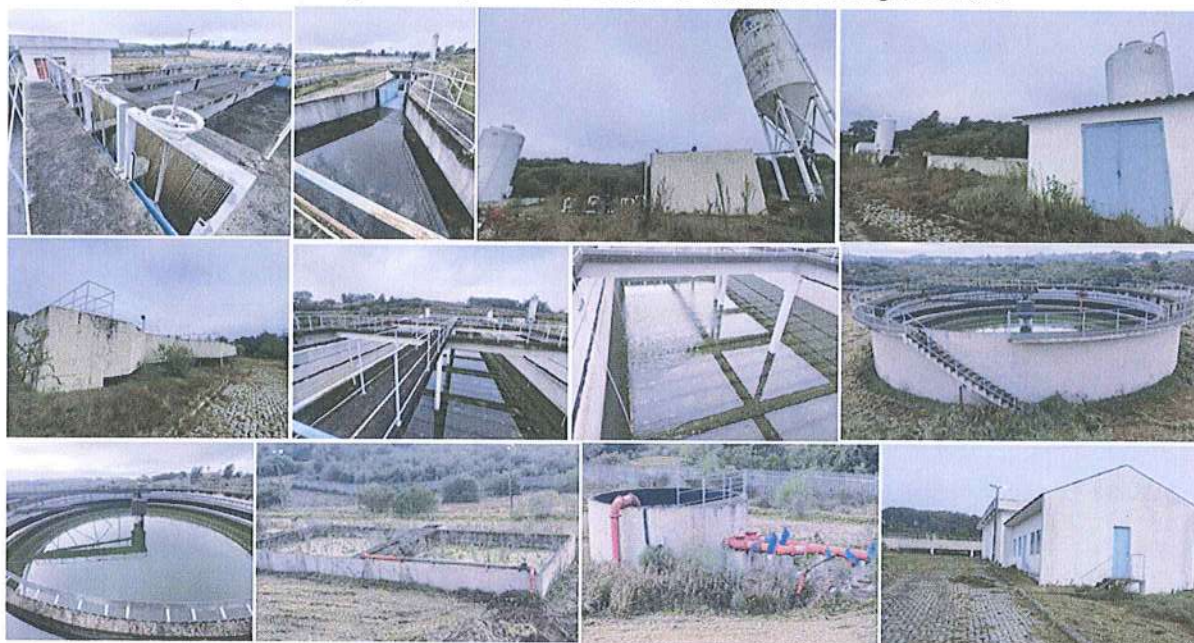
Figura 21: Registros fotográficos da Estação de Tratamento de Esgoto Central.
