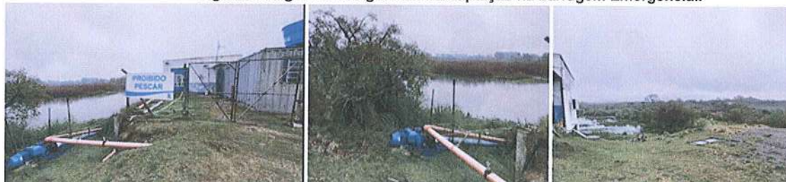
Figura 8: Registros fotográficos da captação na barragem Emergencial.
