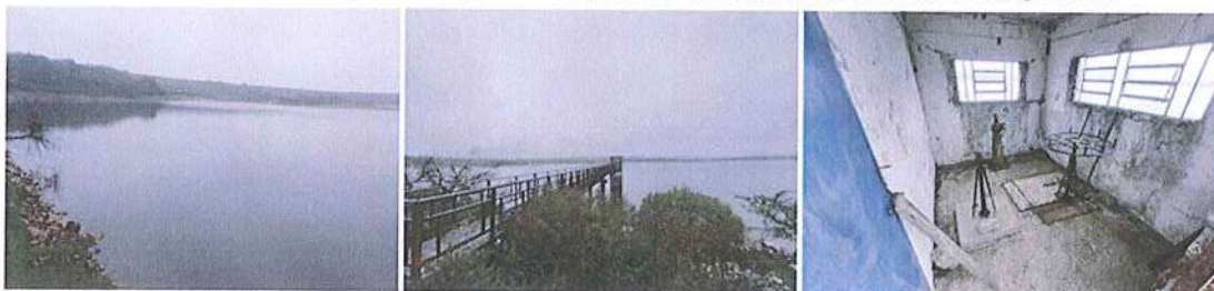
Figura 7: Registros fotográficos da captação na barragem Sanga Rasa.
