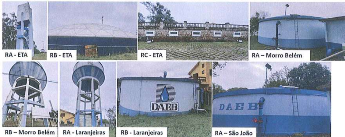
Figura 17: Registros fotográficos dos reservatórios fiscalizados.
