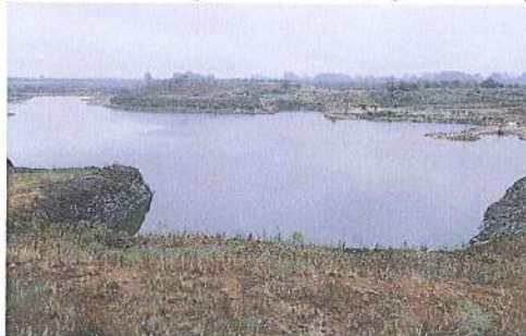
Figura 9 Registros fotográficos da barragem Arvorezinha que está em processo de construção.
