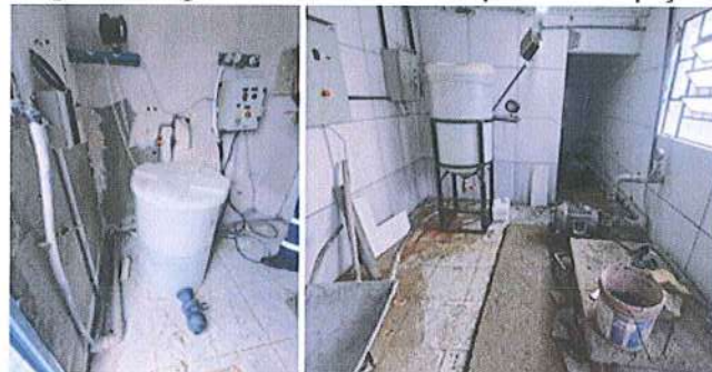
Figura 12: Registros fotográficos do tratamento simplificado dos poços vistoriados.
