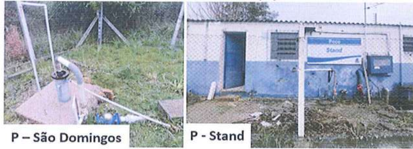
Figura 11: Registros fotográficos dos poços vistoriados.
