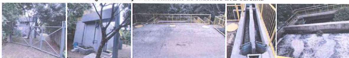
Figura 7: Estação de tratamento de efluentes ETE Carolina
