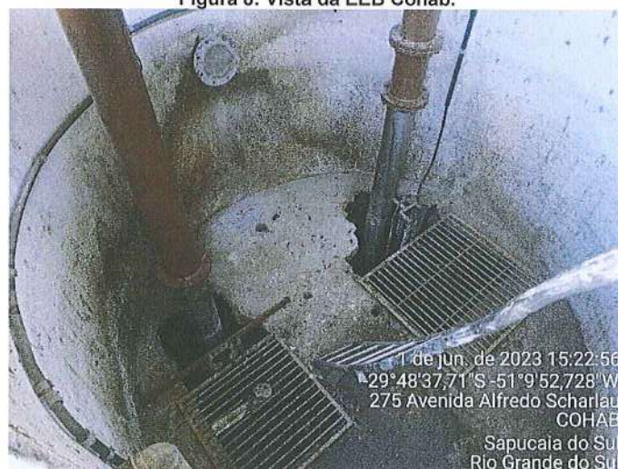
Figura 8: Vista da EEB Cohab.
