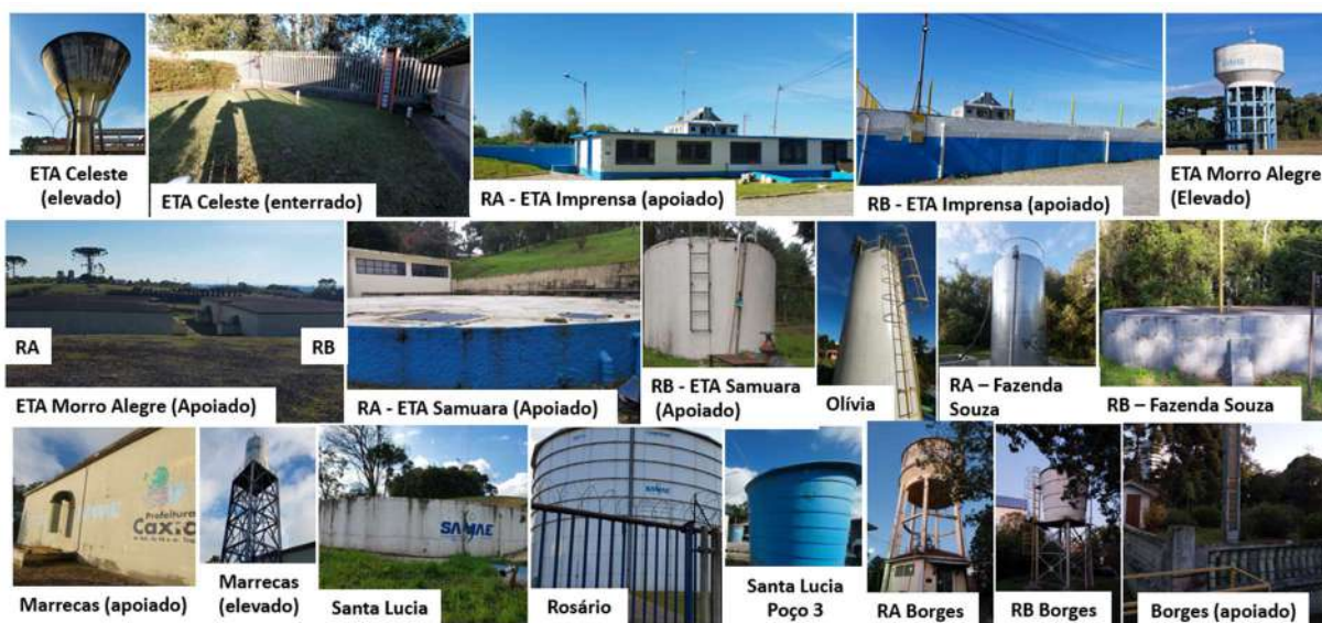
Figura 33: Registros fotográficos dos reservatórios vistoriados.
