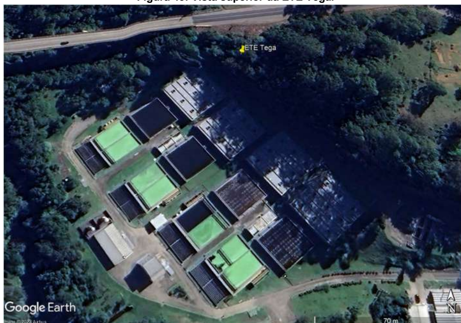
Figura 45: Vista superior da ETE Tega.
