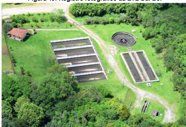
Figura 49: Registro fotográfico da ETE Dal Bó.
