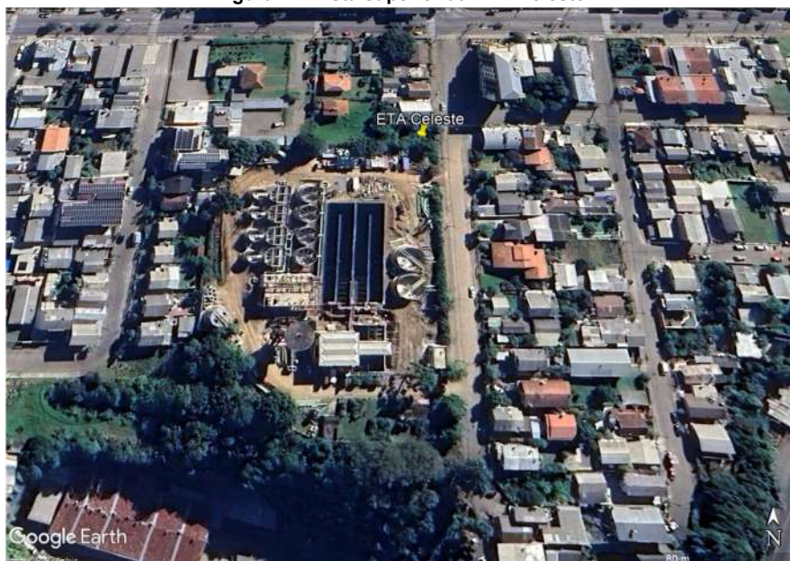
Figura 27: Vista superior da ETA Celeste.
