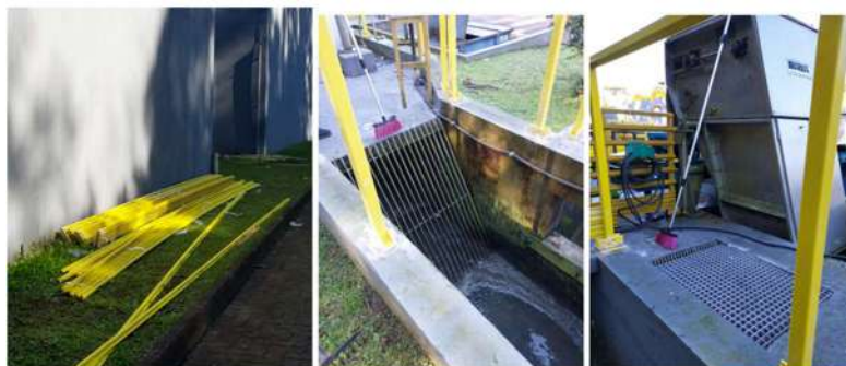
Figura 44: Obras que estão sendo realizadas na ETE Belo.
