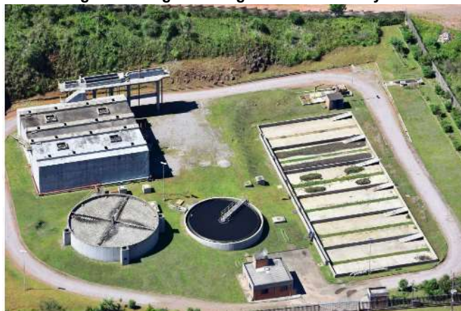
Figura 51: Registro fotográfico da ETE Canyon.
