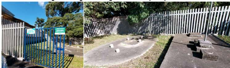
Figura 52: Registros Fotográficos do Tanque Séptico Coletivo.
