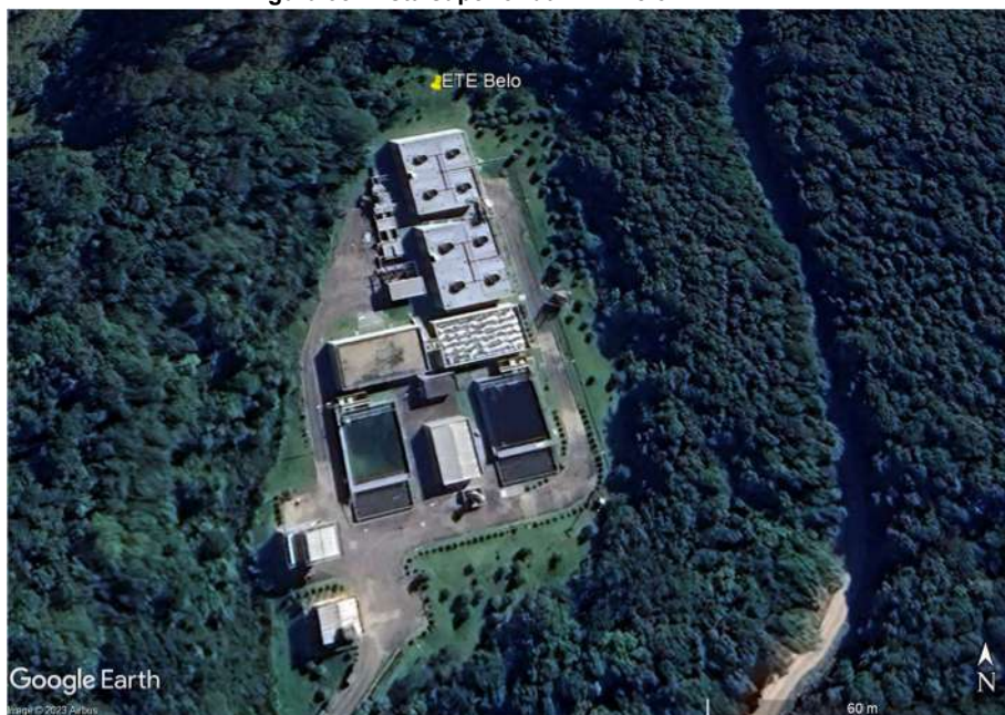
Figura 38: Vista superior da ETE Belo.
