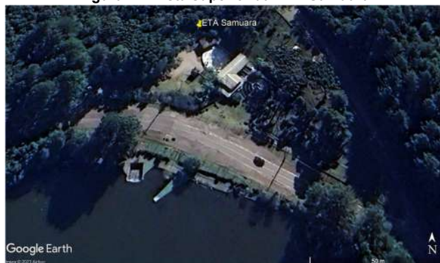
Figura 22: Vista superior da ETA Samuara.
