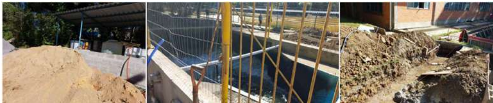
Figura 17: Obras sendo realizadas na área do parque da ETA.
