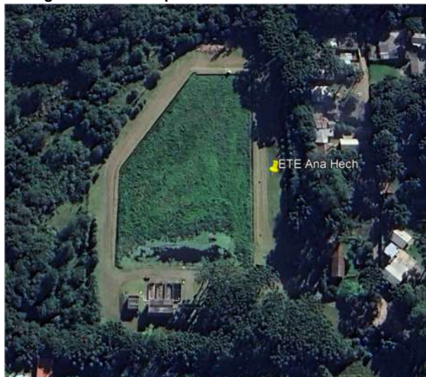
Figura 47: Vista superior da ETE Ana Hech.
