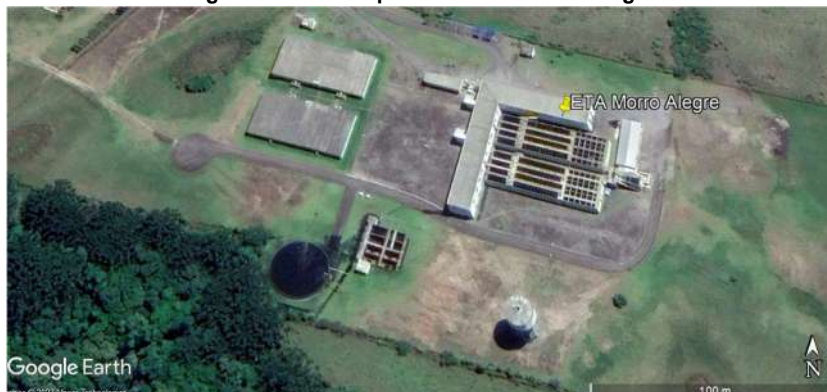
Figura 18: Vista superior da ETA Morro Alegre.
