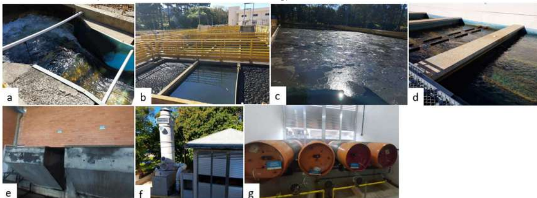
Figura 13: Registros fotográficos das estruturas da ETA: a) Calha Parshall; b) Floculador; c) Decantador; d) Filtro; e) Tina de carvão ativado; f) Local de armazenamento de cloro; g) Cilindros de cloro.
