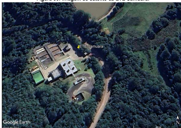
Figura 36: Imagem de satélite da ETE Samuara.
