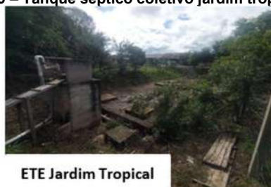
Figura 9 – Tanque séptico coletivo jardim tropical
