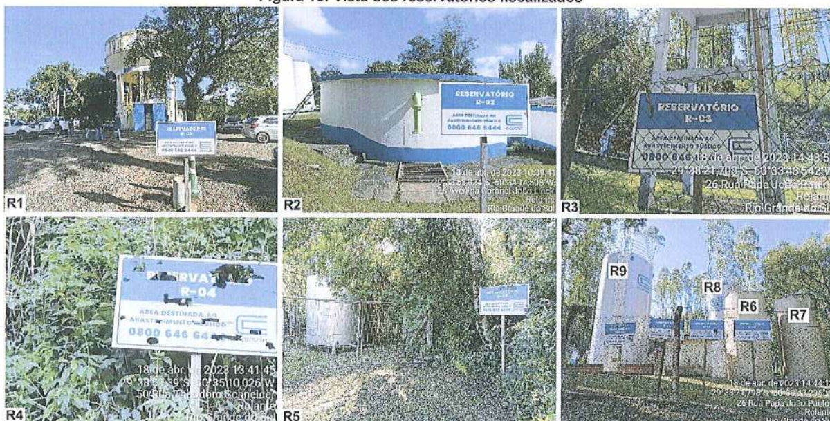
Figura 13: Vista dos reservatórios fiscalizados
