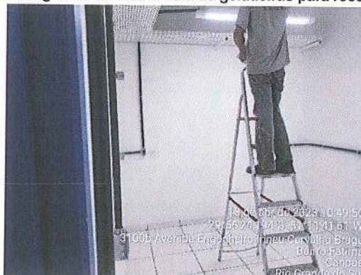
Figura 2: Registro fotográfico da futura sala de geladeiras para recepção de amostras.
