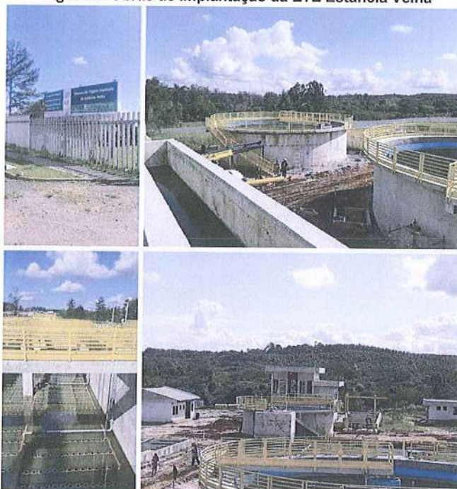
Figura 1: Obras de implantação da ETE Estância Velha
