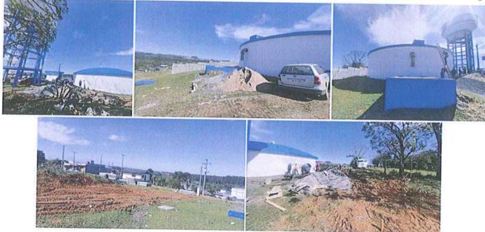
Figura 1 – Obra para cercamento de dois reservatórios e uma das estações elevatórias de água.
