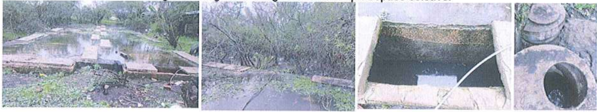
Figura 4: Registros fotográficos do tanque séptico coletivo.
