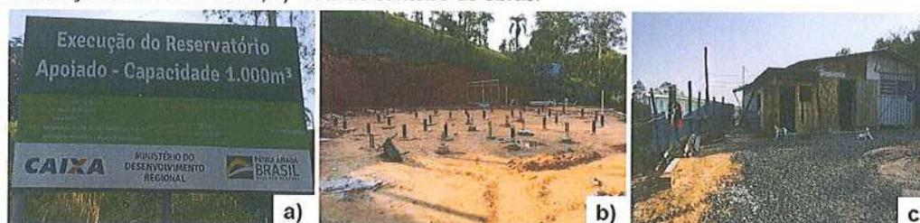
Figura 3: Registros fotográficos da visita às obras do reservatório em 2021. a) Vista do canteiro de obras; b) Fundações do reservatório.
