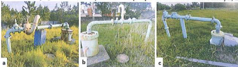
Figura 3: Vista dos poços localizados próximos ao parque da ETA Atlântida Sul. A) ...; b) ... c) ...
