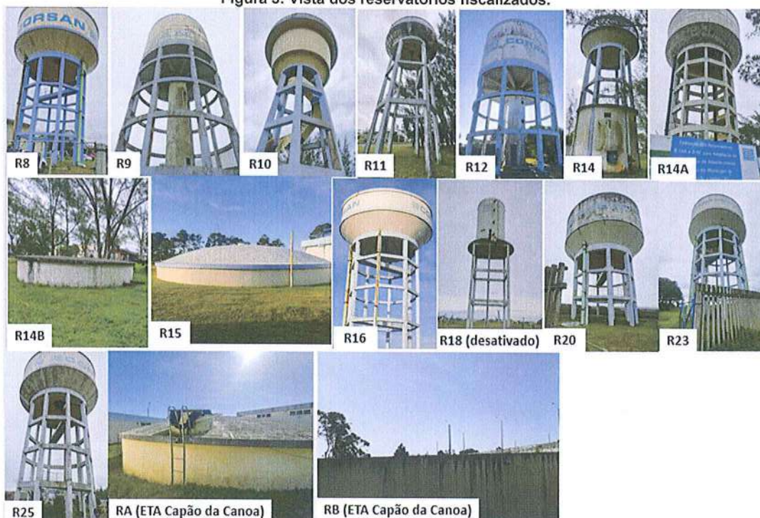
Figura 5: Vista dos reservatórios fiscalizados.
