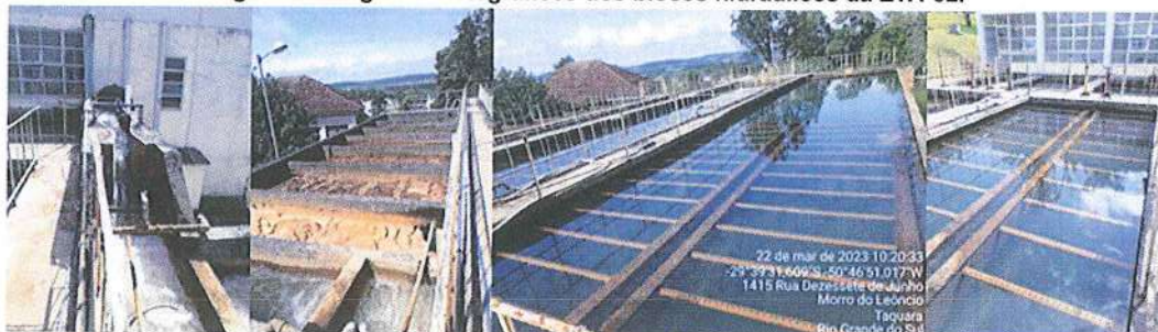
Figura 10: Registros fotográficos dos blocos hidráulicos da ETA-02.
