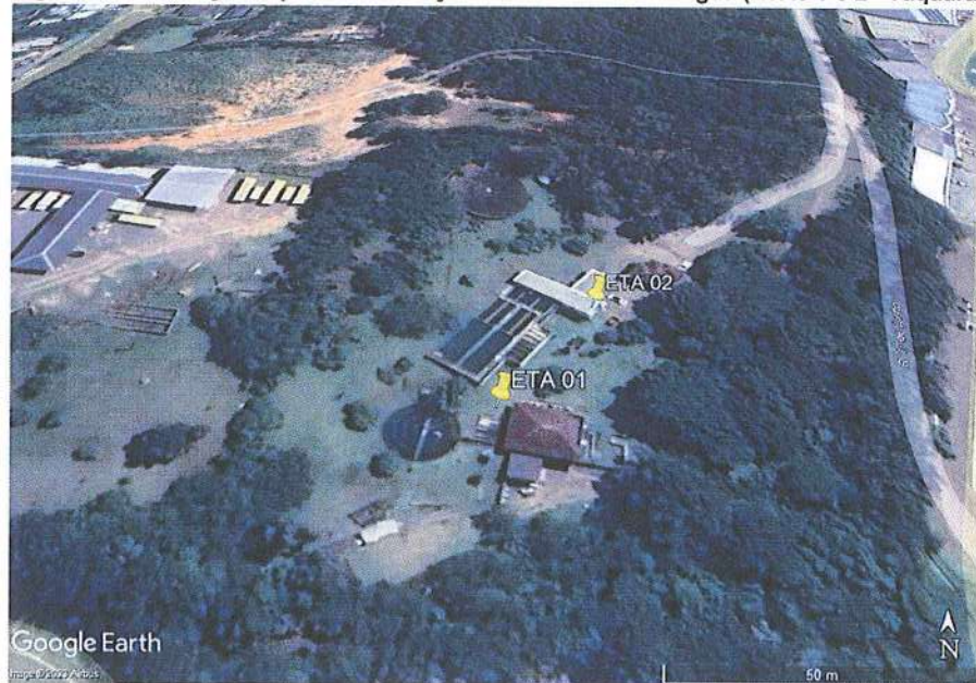
Figura 8: Localização espacial da Estação de Tratamento de Água (ETAs 1 e 2 - Taquara).
