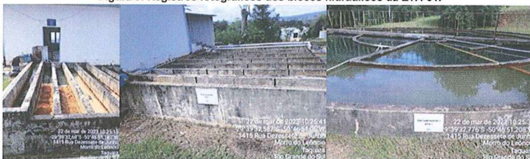
Figura 9: Registros fotográficos dos blocos hidráulicos da ETA-01.
