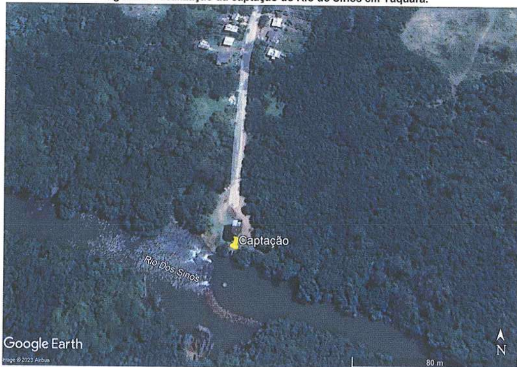
Figura 4: Localização da captação do Rio do Sinos em Taquara.
