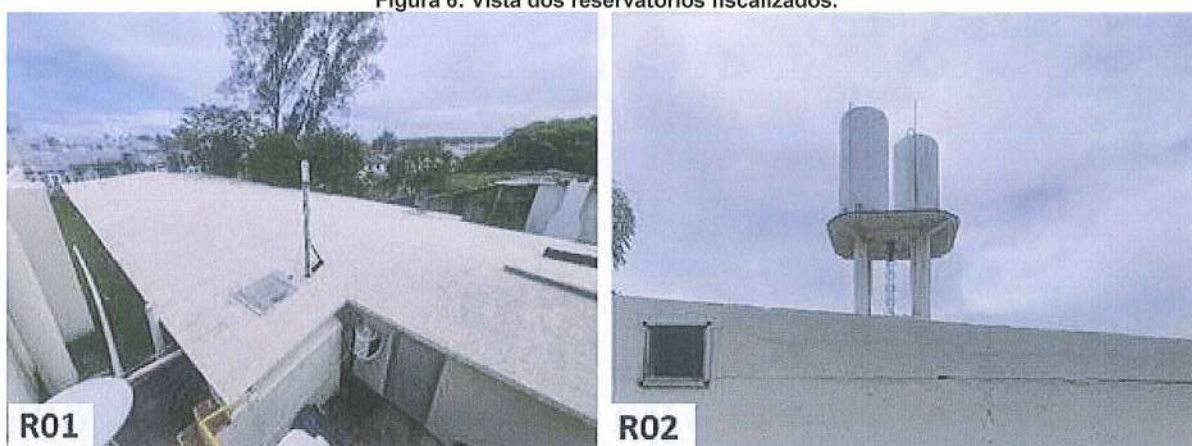
Figura 6: Vista dos reservatórios fiscalizados.
